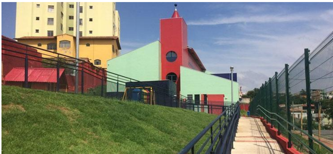
Foto 1: Entrada e rampa de acesso à UMEI.
