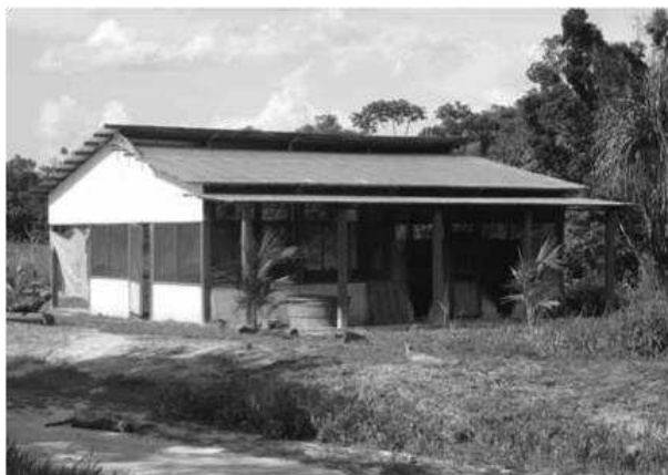
Figura 64 - Casa de alvenaria construída pela Secretaria de Estado de Extensão Agroflorestal e Produção Familiar – Cruzeiro do Sul – Vale do Juruá-AC
