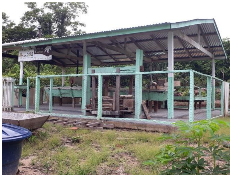
Figura 11 - Vista lateral da Casa de Farinha Modelo Uarini de Bauana – Alvarães-AM
