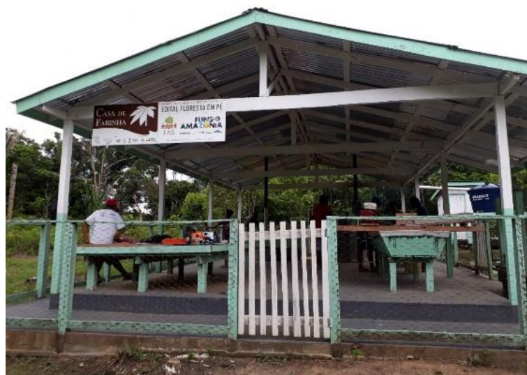
Figura 9 - Vista frontal da Casa de Farinha Modelo Uarini de Arraia – Alvarães-AM
