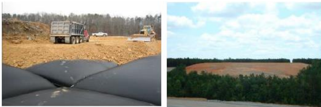
Figura 2.6 – Processo de cobertura do empilhamento de tubos
