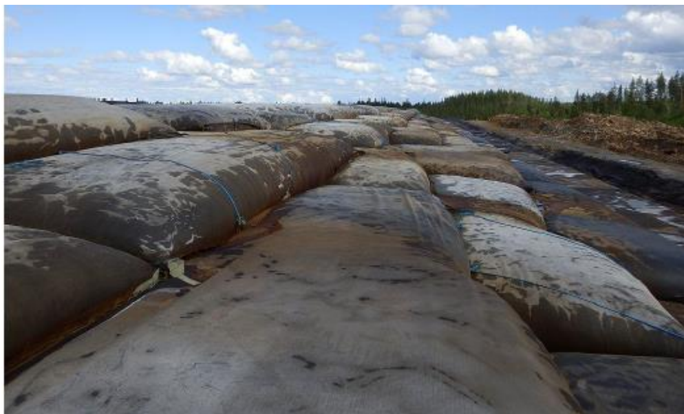
Figura 2.8 – Quinta camada de tubos geotêxteis desaguados
