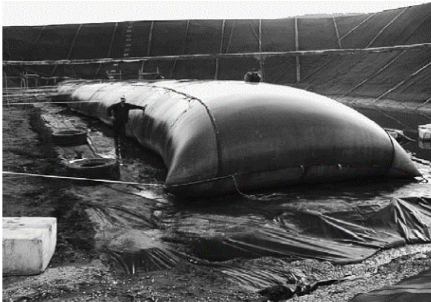
Figura 2.3 – Tubo geotêxtil durante o processo de desaguamento
