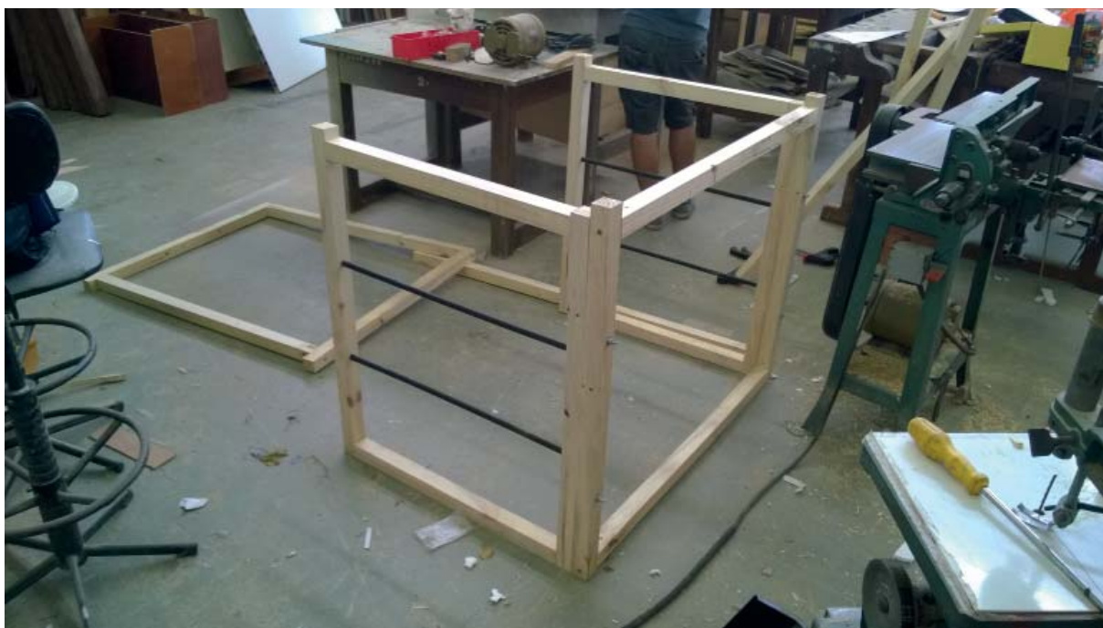
Figura I.9 Execução do sistema de quadros e parafusos Imagem: acervo pessoal
