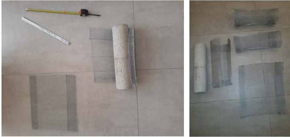
Figura 7.15 - Dobramento das Telas.
