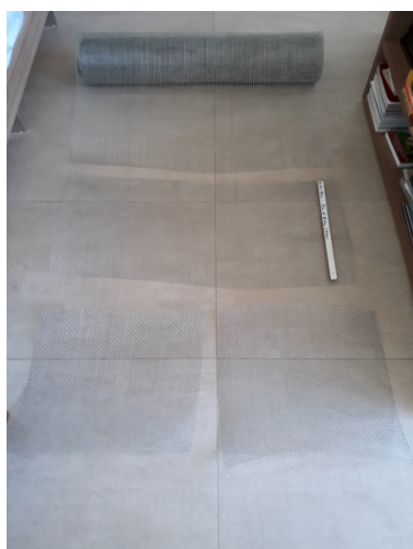
Figura 7.14 - Corte das Telas e Confeção dos Ganchos da Ancoragem por Traspasse.
