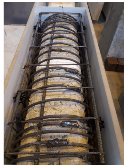
Pilaretes e Armaduras Instalados Detalhe dos 5 cm de Isopor
