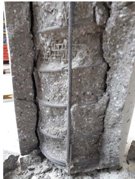
Após retirada da prensa - detalhe
