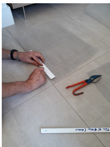
Figura 7.14 - Corte das Telas e Confeção dos Ganchos da Ancoragem por Traspasse.
