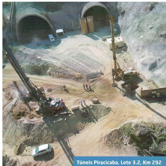
Figura 3.5 - Túnel Piracicaba com 825 m de extensão Fonte: DNIT (2018a)
