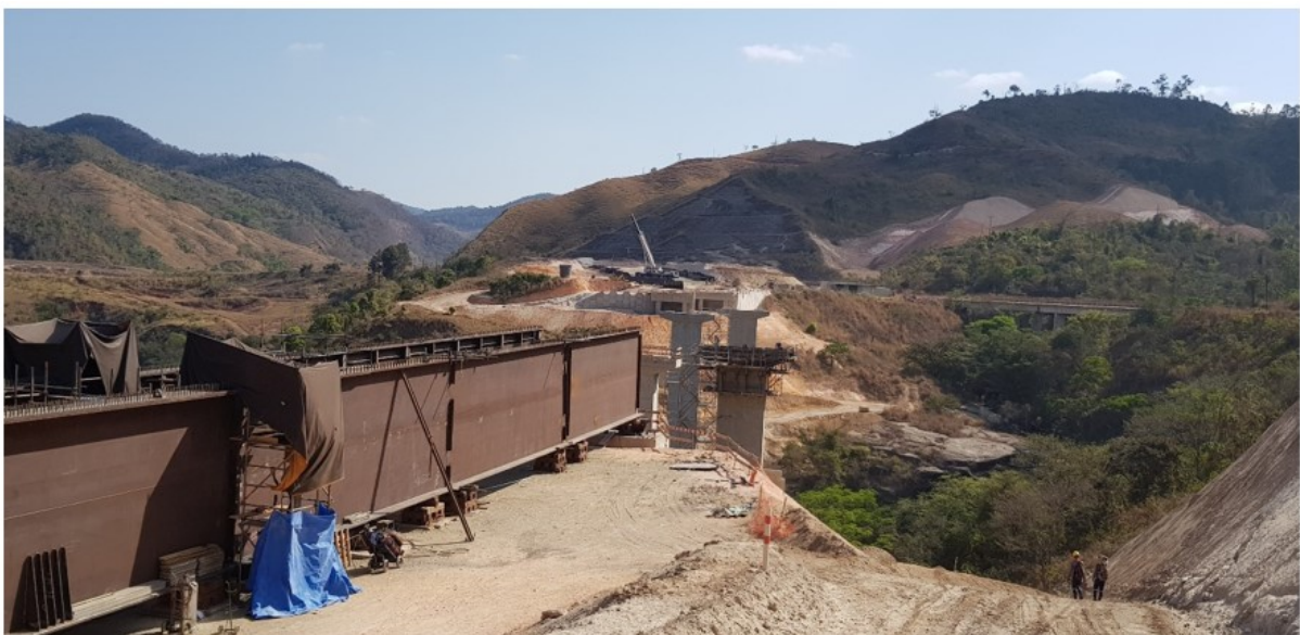
Figura 4.12 - Preparação para lançamento das vigas em aço – Setembro 2019 Fonte: Autor (2019)
