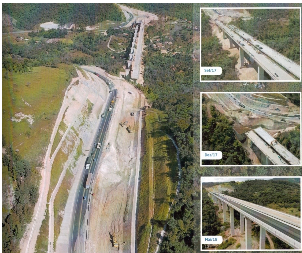
Figura 3.3 - Alteração de traçado e viaduto de 600m Fonte: DNIT (2018a)
