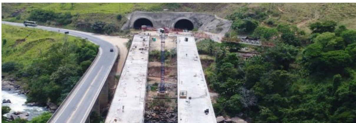
Figura 3.6 - Ligação entre pontes e túneis no trecho escolhido para a pesquisa Fonte: DNIT (2019)
