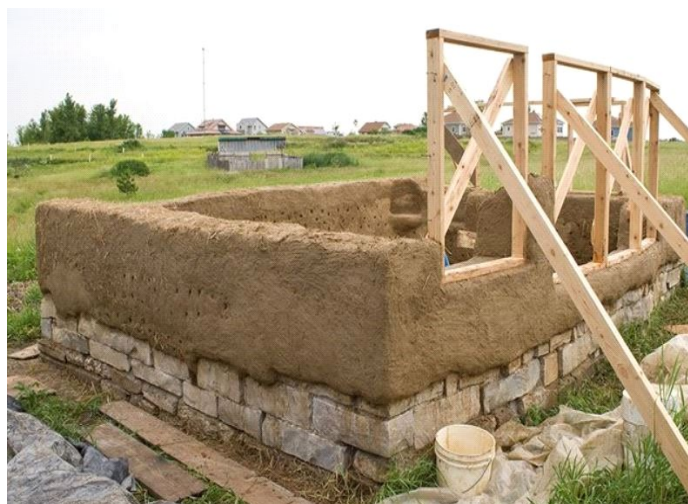
Figura 7 - Construção da parede de cob, com detalhe na fundação e os caixilhos das janelas
