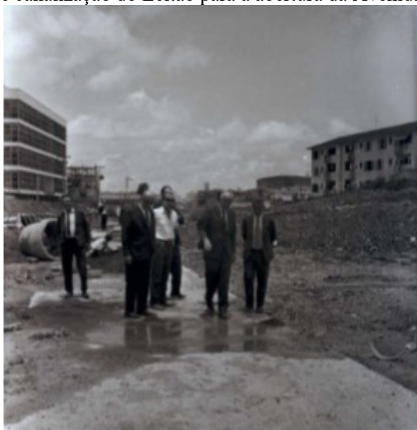
Figura 14 - Obras de canalização do Leitão para a abertura da Avenida Prudente de Morais
