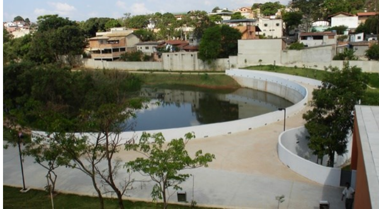
Figura 6 - Lagoa pluvial no Parque Primeiro de Maio em Belo Horizonte.
