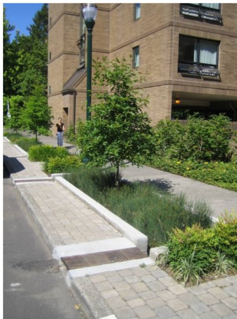
Figura 4 - Exemplo de canteiro pluvial
