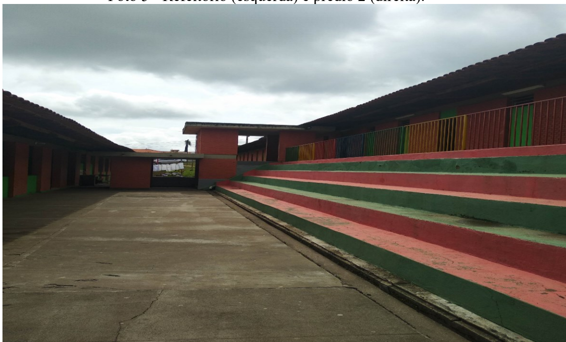
Foto 5 - Refeitório (esquerda) e prédio 2 (direita).
