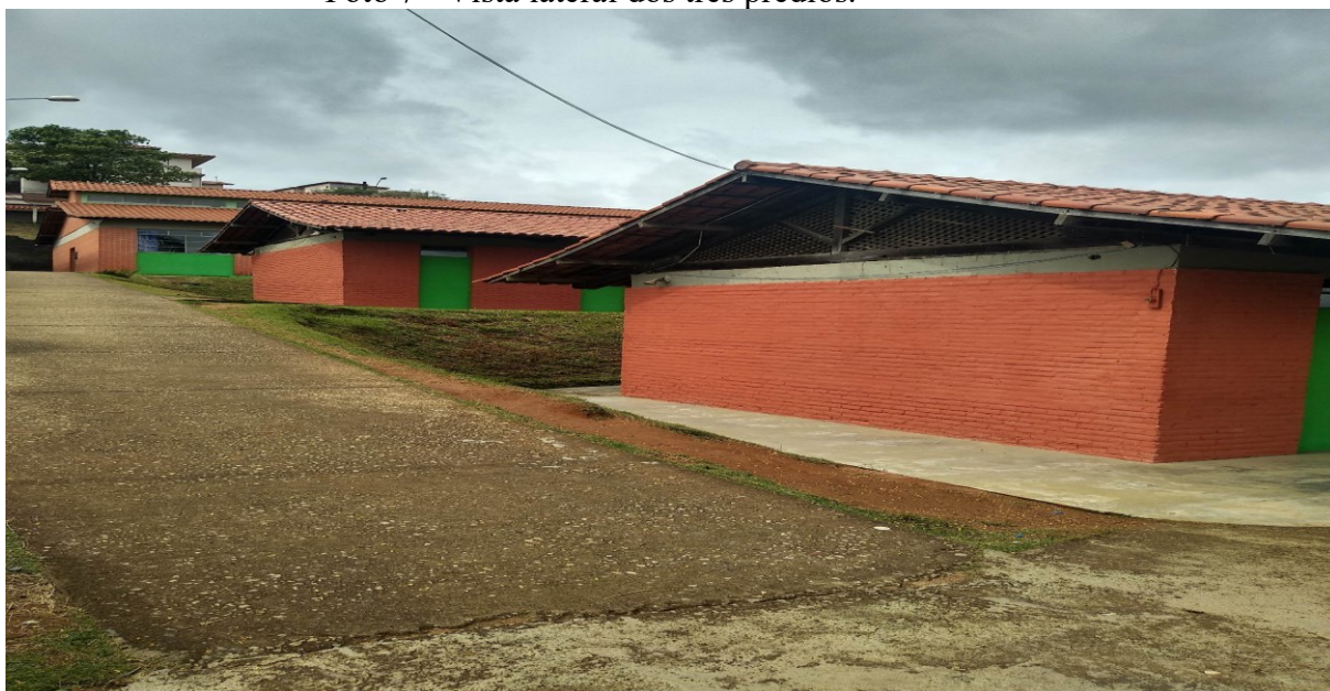
Foto 7 - Vista lateral dos três prédios.
