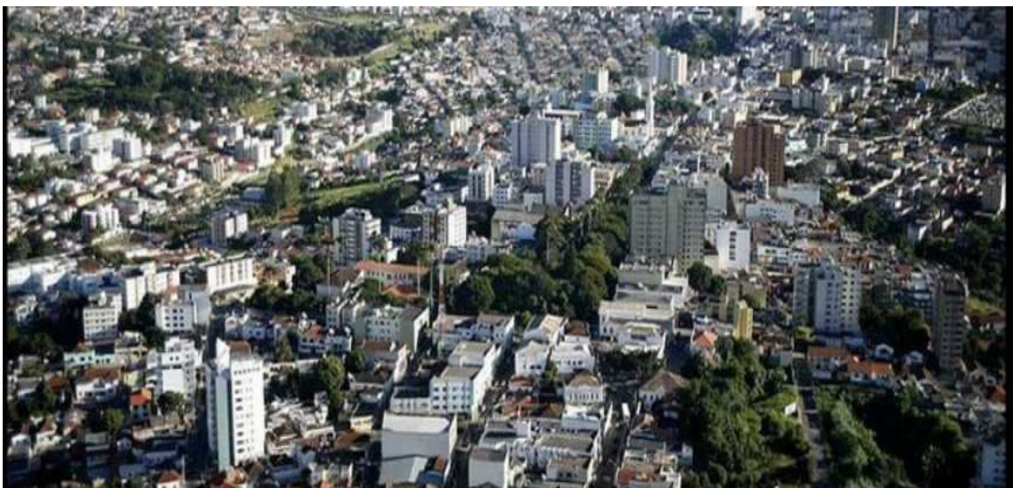
Figura 1: Vista aérea de parte do perímetro urbano da Cidade de Lavras - MG
