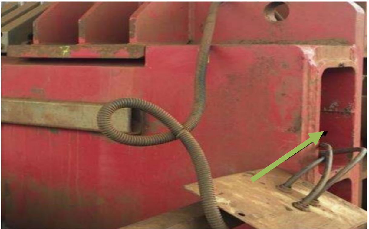
Figura 81 – Reforço 01 – Interferência das Talas de Reforço com a Parede do Tubo.
