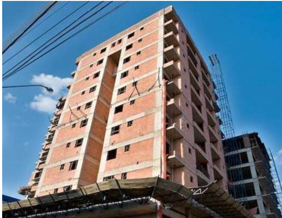
Figura 2 – Edifício em estrutura convencional de concreto armado e alvenaria
