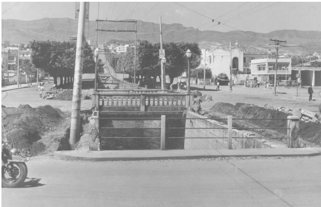
Figura 146 – Início das obras de ampliação do canal do Canal do Acaba Mundo na Avenida Afonso Pena.
