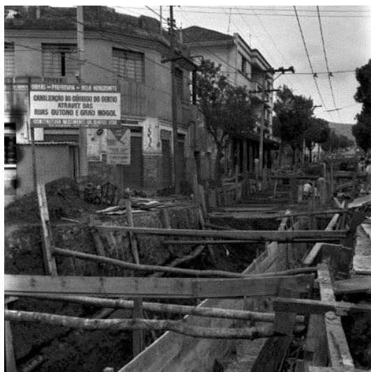
Figuras 143 e 144 – Canalização dos córregos Acaba Mundo e Gentio, ao longo das ruas Grão Mogol e Outono, no Bairro Carmo, no fim dos anos 1960.
