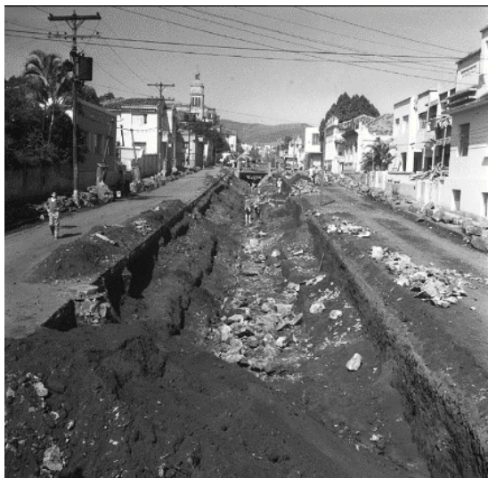
Figuras 123 e 124 – Remoção da alvenaria do Canal do Acaba Mundo, entre a Avenida Getúlio Vargas e Rua Cláudio Manoel em 1963, com a finalidade de alargar sua calha, que posteriormente seria coberta. Na foto da direita, a tubulação aparente parecer ser um interceptador de esgoto.
