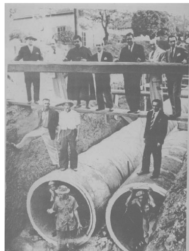
Figura 104 – Alargamento do canal da Rua Professor Moraes, para evitar as inundações.
