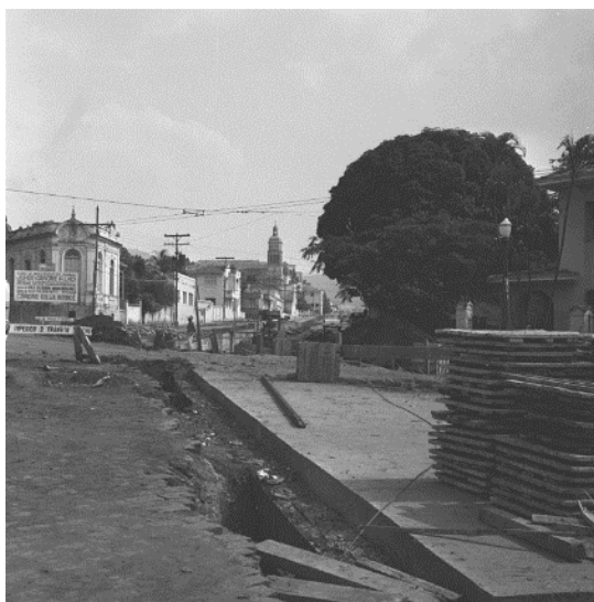
Figuras 147 e 148 – Alargamento e revestimento do Canal do Acaba Mundo na Avenida Afonso Pena, entre 1972-75.
