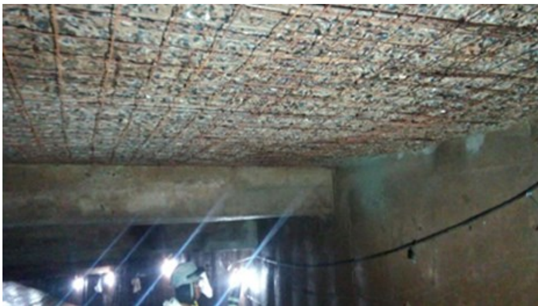
Figura 188 – Telas posicionadas na laje de teto.
