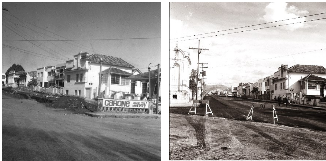
Figura 127 – Início das obras de cobertura do canal do Acaba Mundo em 1963, na gestão de Jorge Carone Filho.
