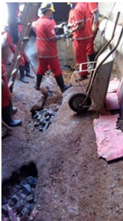
Figura 184 e 185 – Situação original da laje de piso, recebendo recomposição do subleito e da base da galeria.
