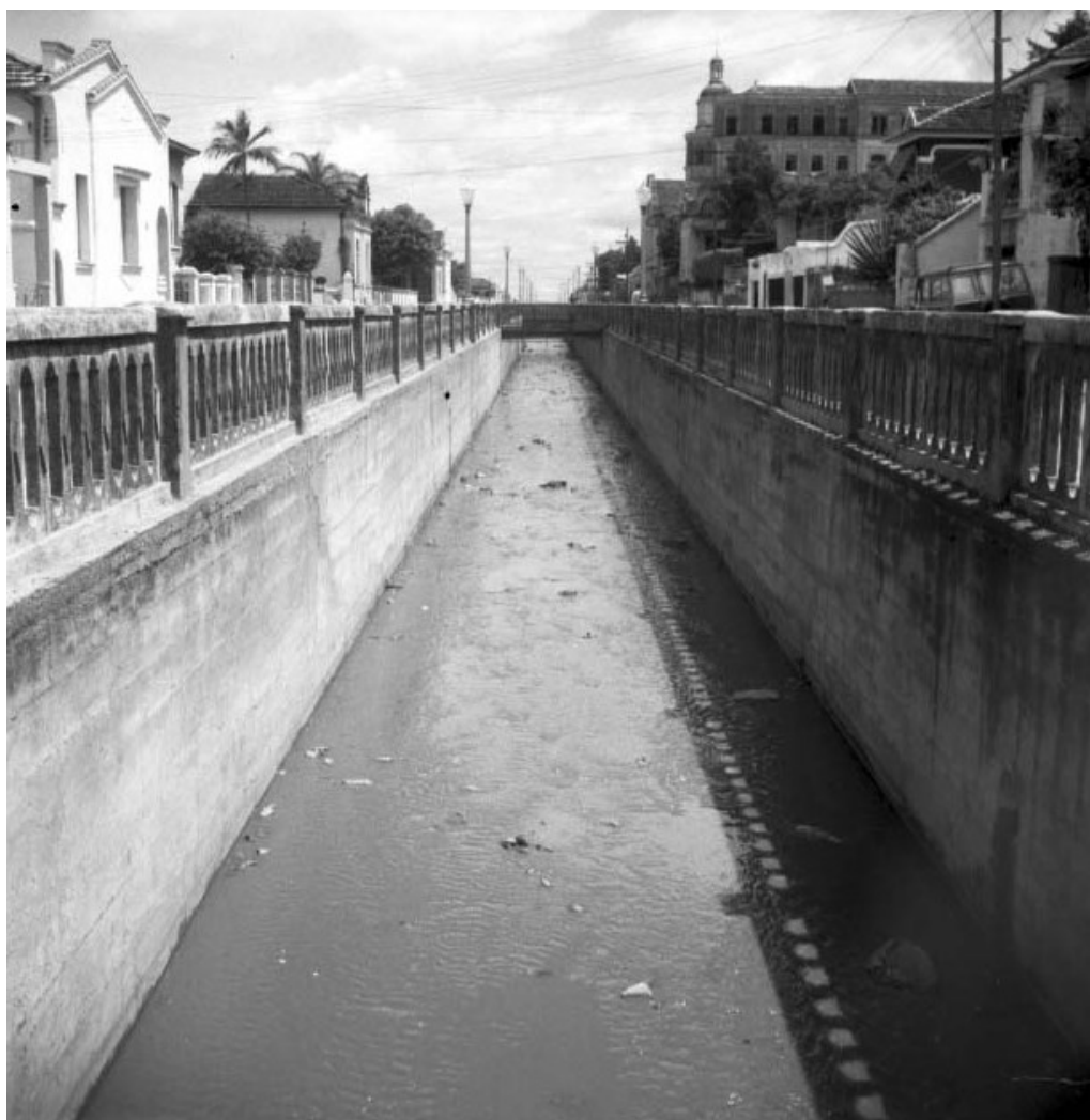
Figura 106 – Canal do Córrego Acaba Mundo, já apresentando sujeira e detritos, em 1950, na Rua Professor Moraes.
