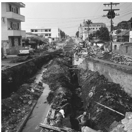
Figura 125 – Remoção da alvenaria do Canal do Acaba Mundo, entre a Avenida Getúlio Vargas e Rua Cláudio Manoel em 1963, com a finalidade de alargar sua calha, que posteriormente seria coberta.
