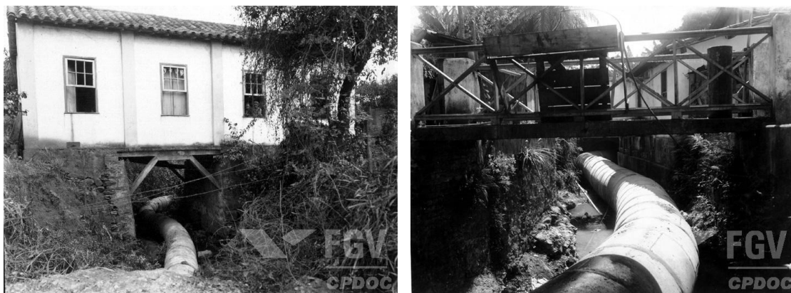
Figuras 54 e 55 – Drenos no antigo leito do Córrego Acaba Mundo, atravessando por entre casas e lotes de particulares.
