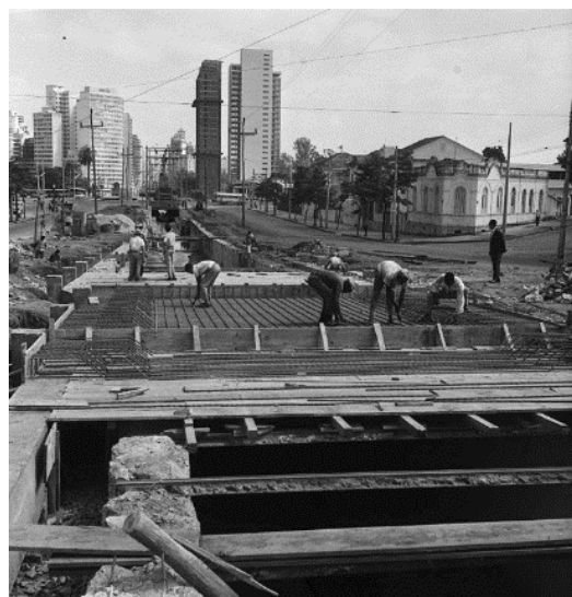
Figuras 147 e 148 – Alargamento e revestimento do Canal do Acaba Mundo na Avenida Afonso Pena, entre 1972-75.
