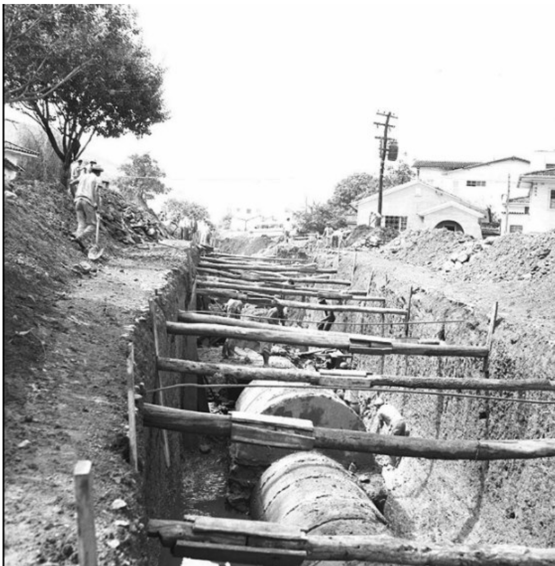
Figura 117 – Canalização do Córrego do Gentio, ao longo da Rua Andaluzita, em 1966.
