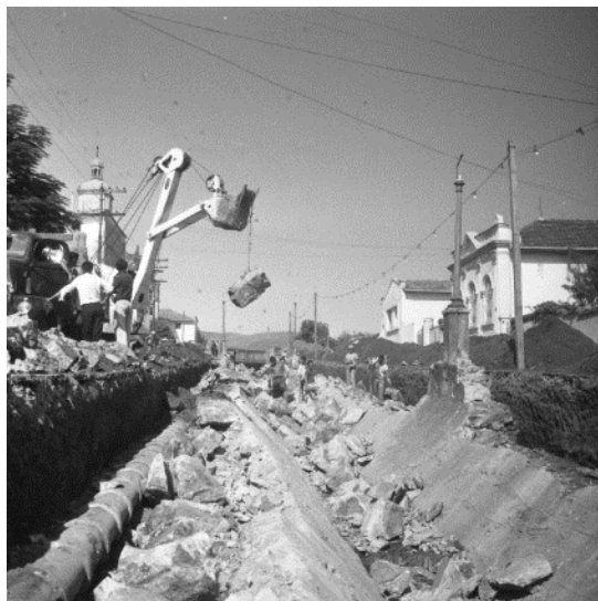
Figuras 123 e 124 – Remoção da alvenaria do Canal do Acaba Mundo, entre a Avenida Getúlio Vargas e Rua Cláudio Manoel em 1963, com a finalidade de alargar sua calha, que posteriormente seria coberta. Na foto da direita, a tubulação aparente parecer ser um interceptador de esgoto.
