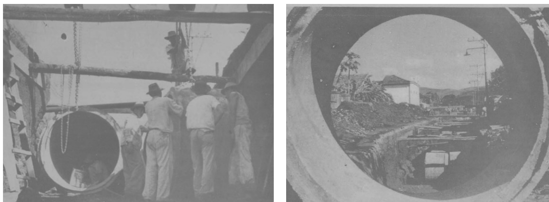
Figura 99 – Trabalho de canalização do Córrego Acaba Mundo, na Rua Rio Grande do Norte, onde foram utilizadas manilhas de 1,50 m de diâmetro.
