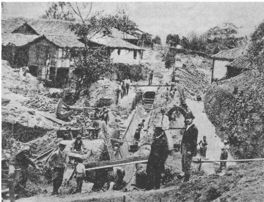
Figura 11 – Trabalho de construção das galerias de tijolos (coletores de maior porte, de forma oval) no Parque Municipal, entre 1896 e 1897, vendo-se ali perto a velha fazenda que morava o Sr. Paul Villon, responsável pelo projeto do parque durante os trabalhos CCNC.
