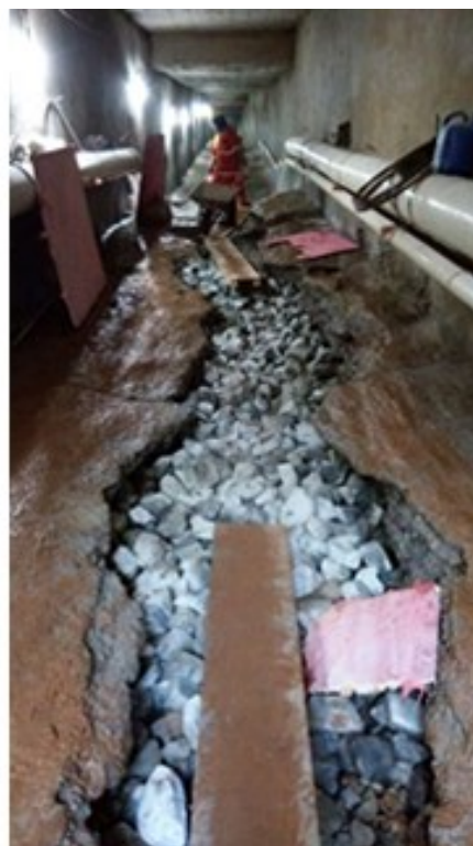
Figura 184 e 185 – Situação original da laje de piso, recebendo recomposição do subleito e da base da galeria.
