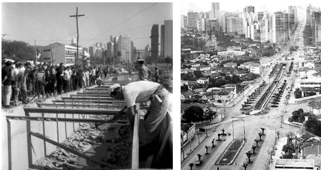
Figura 131 –Obras de canalização do Córrego Acaba Mundo na Avenida Afonso Pena com Rua Rio Grande do Norte, em 1966.
