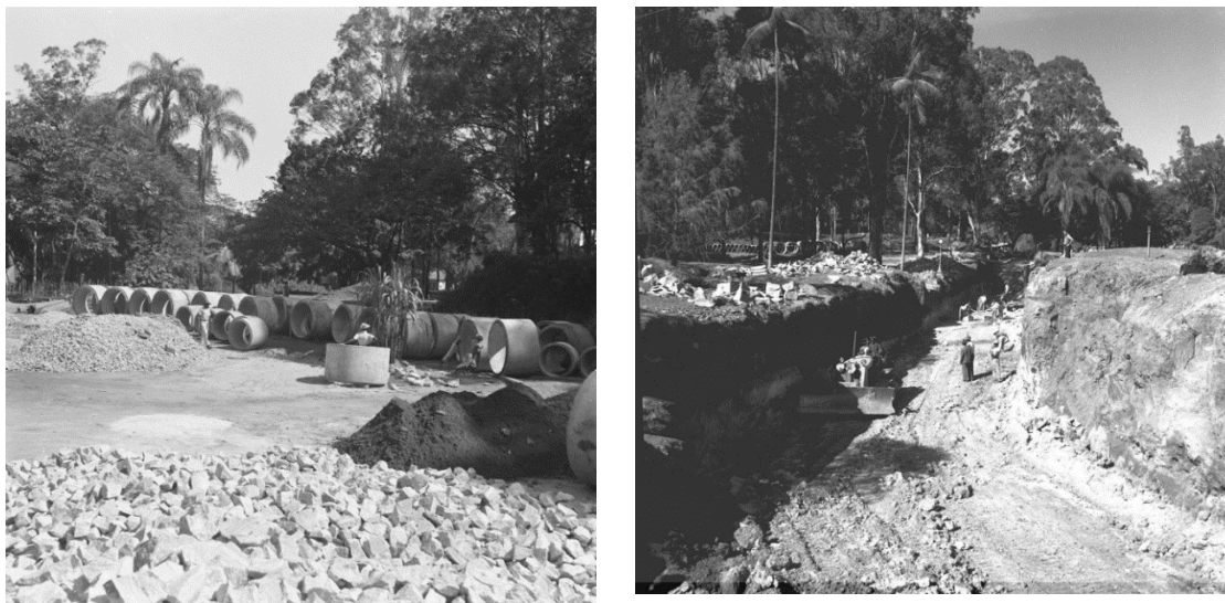
Figuras 114 e 115 – Canalização do Córrego Acaba Mundo (em torno de 600 metros), como medida de saneamento das lagoas do Parque Municipal, empreendidas na gestão de Américo Renné Giannetti, entre 1952-1953.
