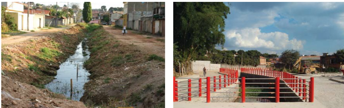
Figuras 95 e 96 – Obras de canalização do Córrego do Cabral, afluente do Córrego Sarandi, e da Avenida Gandhi, no Bairro Serrano, Região da Pampulha, desenvolvidas através do Orçamento Participativo.
