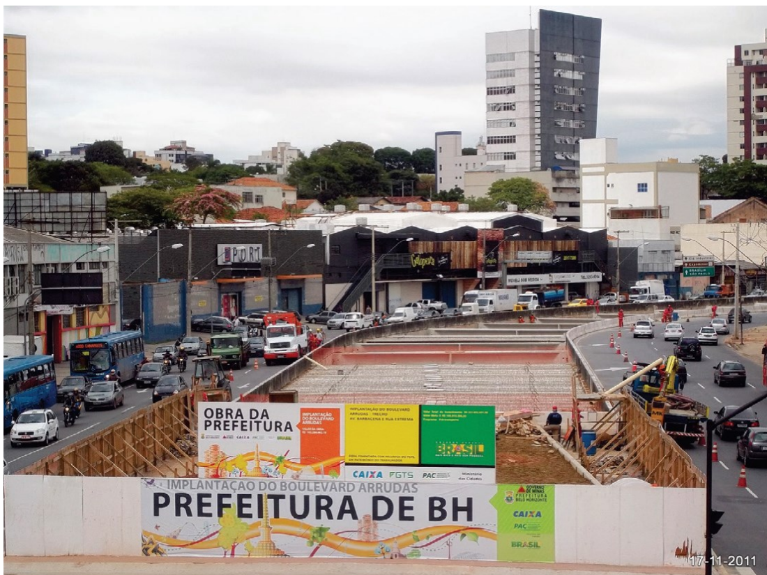
Figura 165 – Obra de execução do Trecho V, do Boulevard Arrudas.
