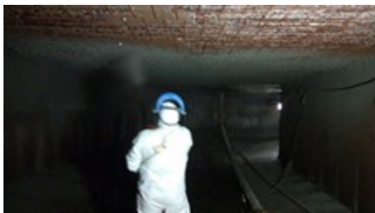
Figuras 189 e 190 – Projeção de argamassa de alto desempenho na laje de teto.
