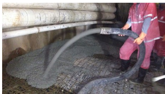
Figura 184 e 185 – Situação original da laje de piso, recebendo recomposição do subleito e da base da galeria.
