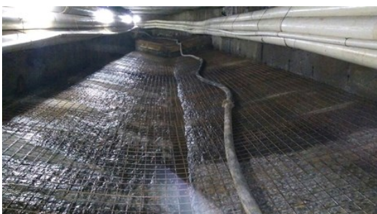
Figura 186 e 187 – Telas posicionadas na laje de piso para a concretagem.
