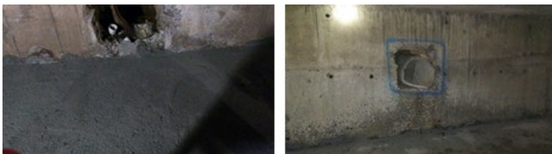
Figura 179 e 180 – Situação original das paredes.
