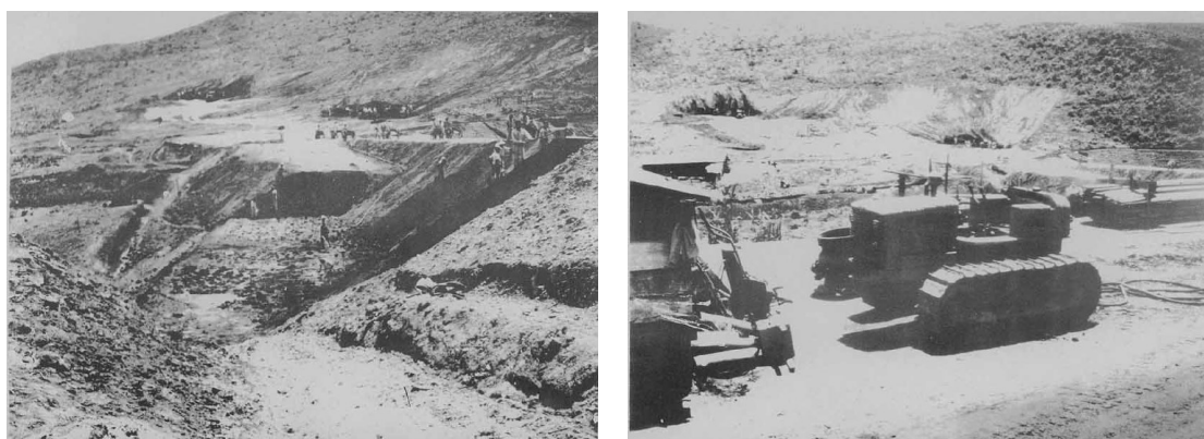
Figura 107 – Serviço de terraplenagem na Barragem do Acaba Mundo.
