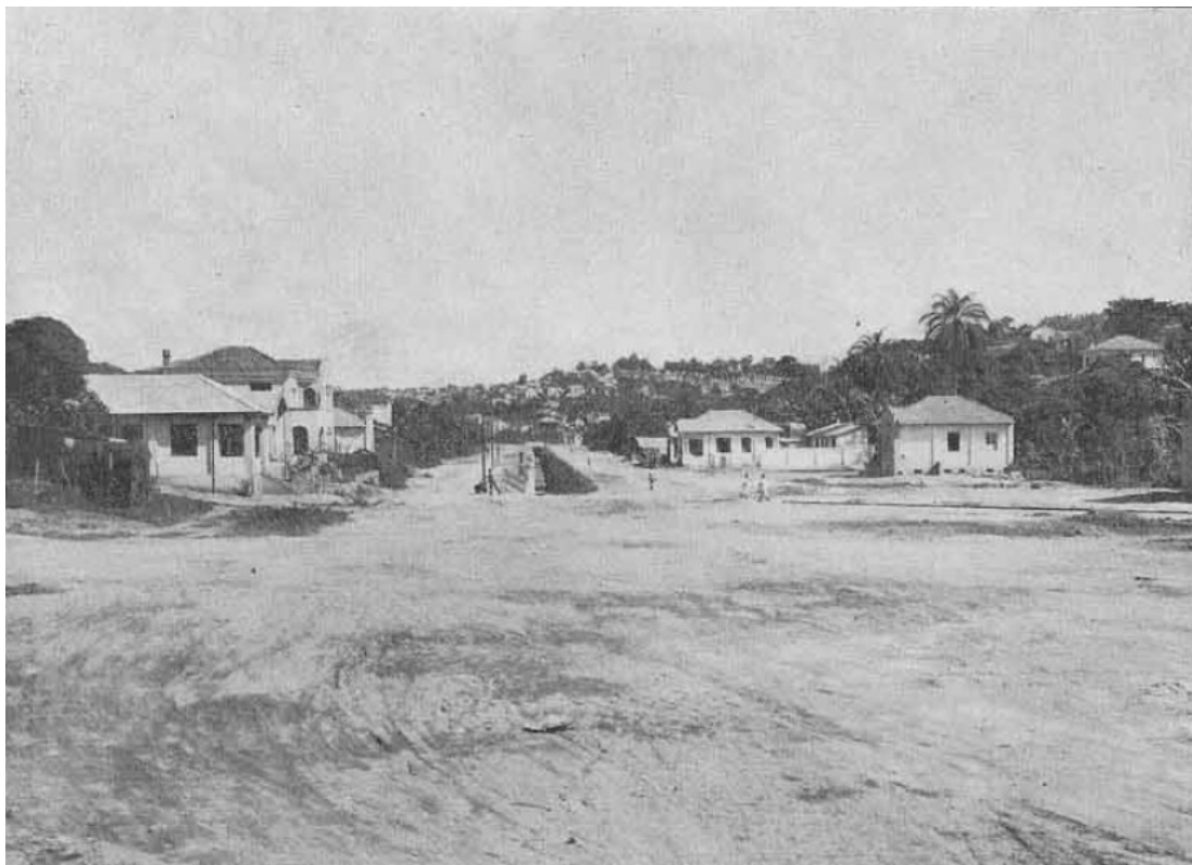
Figuras 74 – Avenida Pedro II, em 1937, sobre o córrego do Pastinho, canalizado e tamponado, e, ao fundo, o córrego em canalização aberta.
