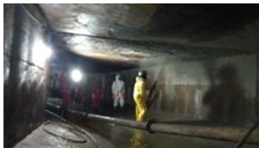
Figuras 189 e 190 – Projeção de argamassa de alto desempenho na laje de teto.
