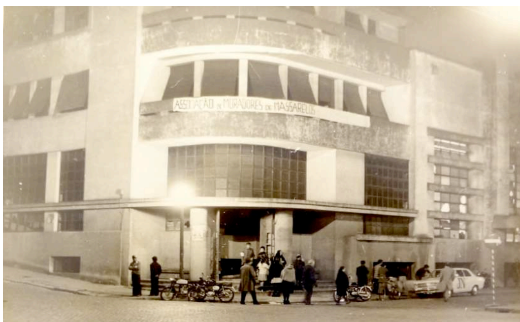
Fig. 31: Entrada dos Armazéns Frigoríficos de Massarelos que se tornaram sede da associação de moradores após a ocupação do edifício realizada em março de 1975 (Espólio fotográfico Alexandre Alves Costa – Centro de Documentação 25 de abril).
