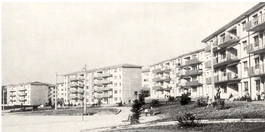
Fig. 26: Bairro camarário do Cerco do Porto (CMP, 1966).
