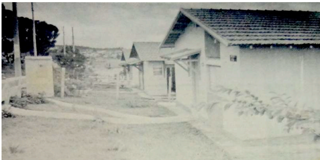
Fig. 14: Vila Betânia (Belo Horizonte). Conjunto habitacional de casas populares financiado pelo BNH. Em 1976, alguns moradores tentarão se articular contra a desapropriação de parte da vila para permitir a duplicação do Anel Rodoviário (JORNAL DOS BAIRROS, n. 4, 1976, p. 7).
