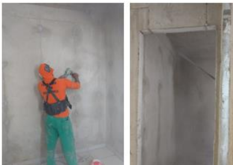
Figura 13 - Lixamento mecânico seguido de hidrojateamento.
