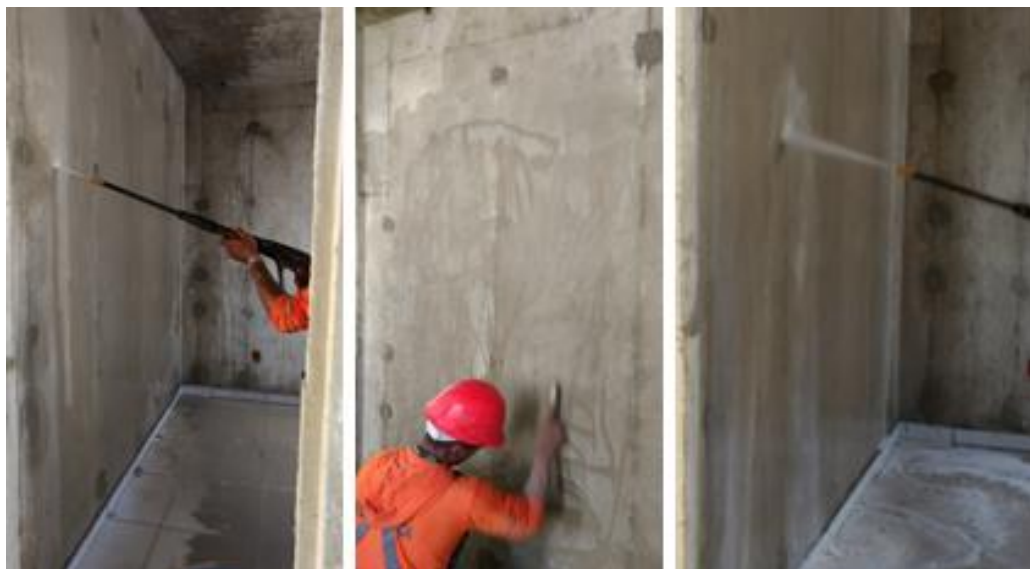
Figura 14 - Escovação manual com detergente seguida de hidrojateamento
