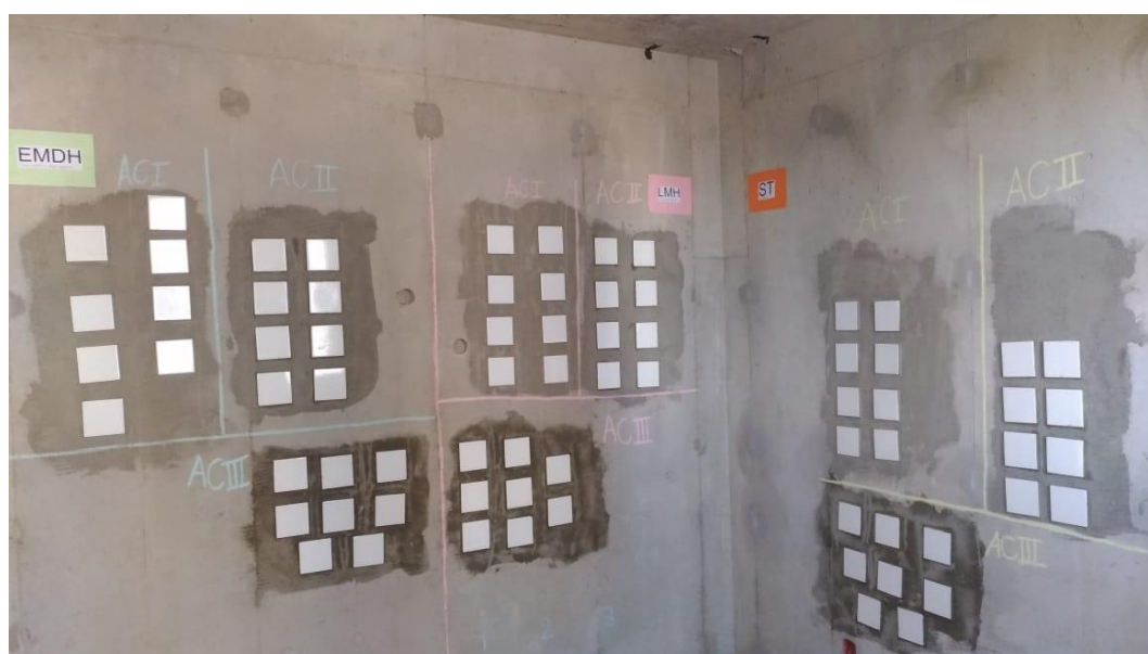
Figura 21 - Cerâmicas assentadas em obra para ensaio de resistência de aderência.
