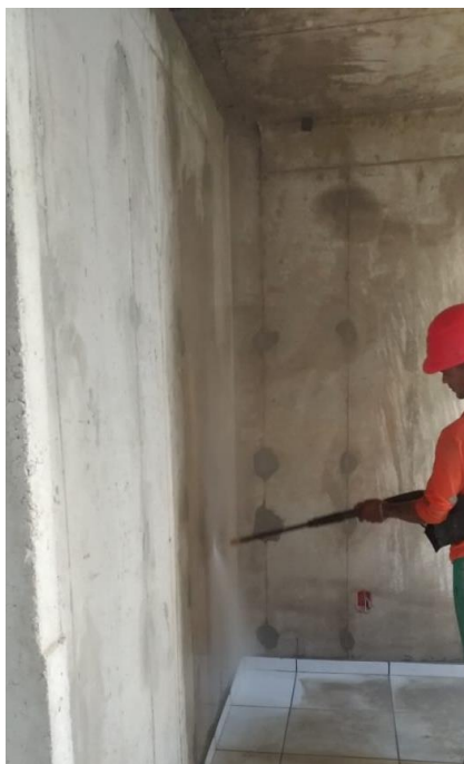
Figura 11 - Lavagem com hidrojateamento
