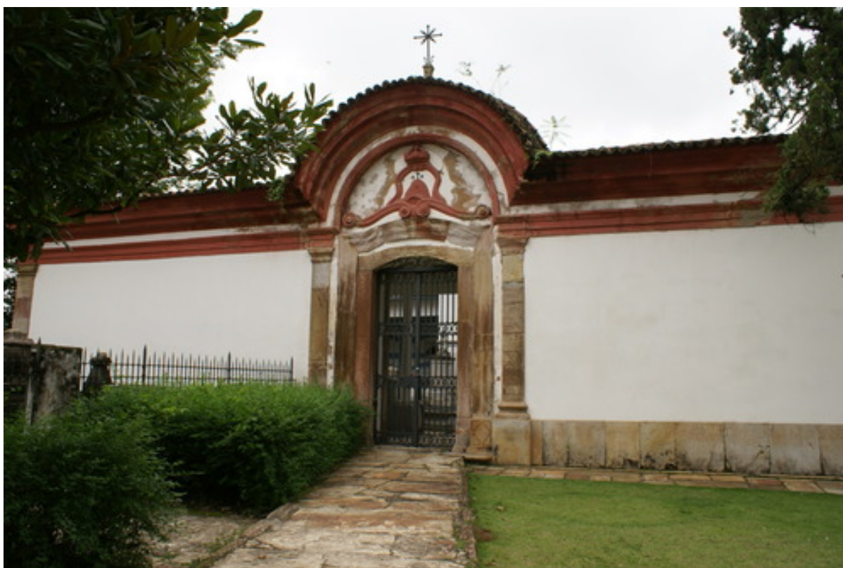
FIGURA 10 – Fachada frontal do cemitério de catacumbas muralhado da Ordem Terceira do Carmo de Ouro Preto. Fonte: Própria.
