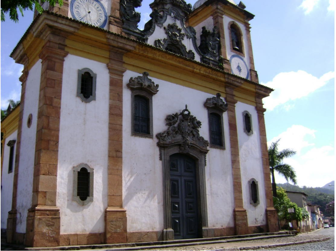
FIGURA 7 – Igreja da Ordem Terceira de Nossa Senhora do Carmo – Sabará Fonte: Própria
