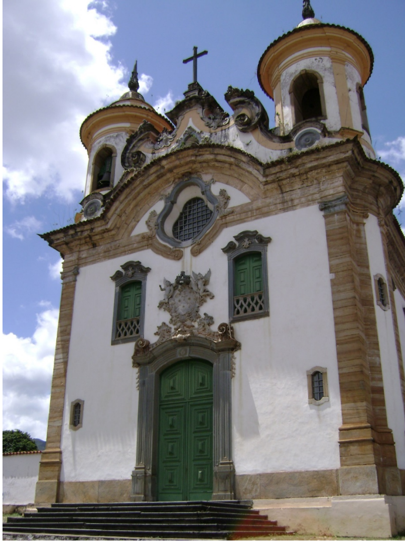
FIGURA 3 – Igreja da Ordem Terceira de Nossa Senhora do Carmo - Mariana Fonte: Própria
