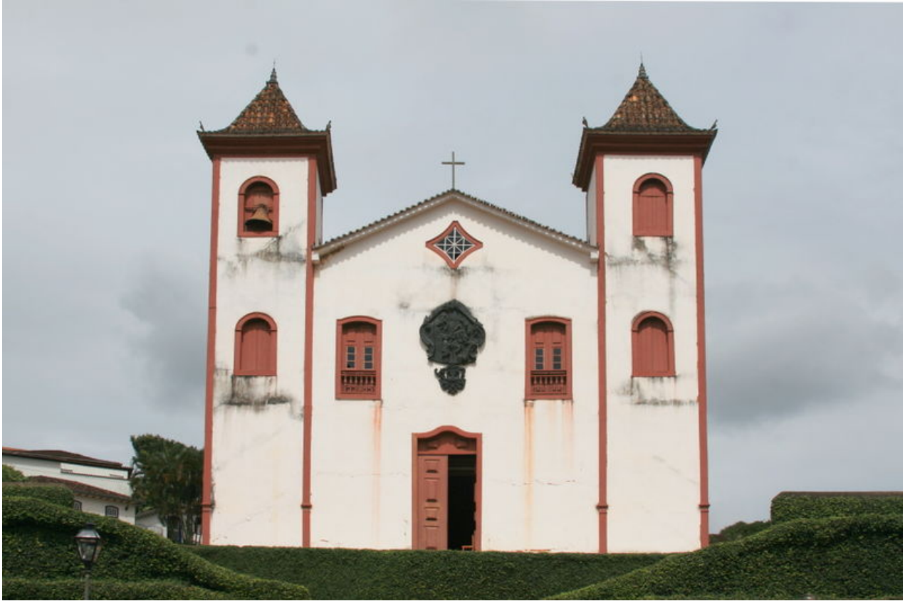
FIGURA 6 – Igreja da Ordem Terceira de Nossa Senhora do Carmo –Serro. Fonte: Própria
