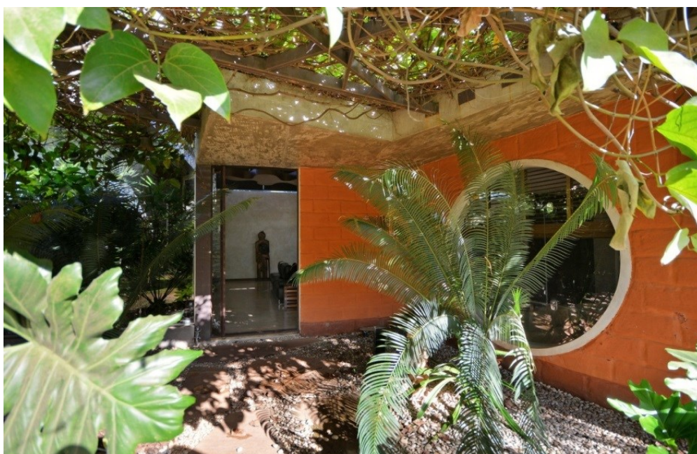
Figura 16: Acesso Principal. Fachada Leste
