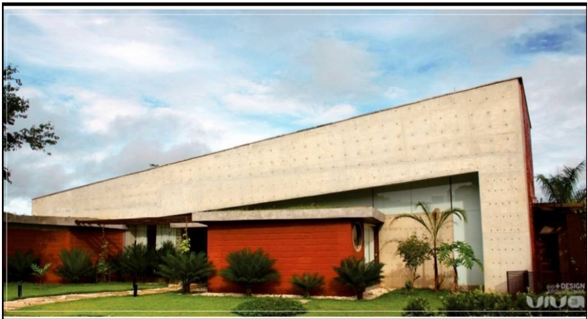
Figura 9: Foto Fachada Leste 1
