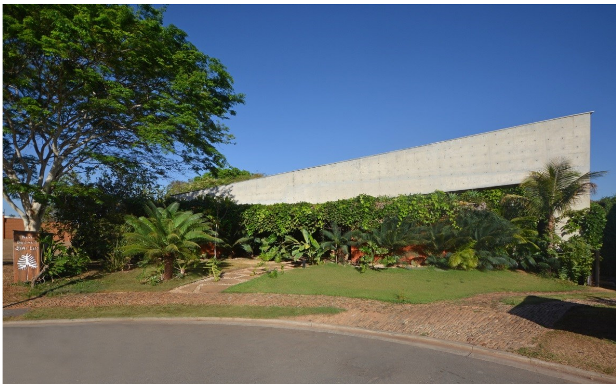
Figura 10: Foto Fachada Leste 2
