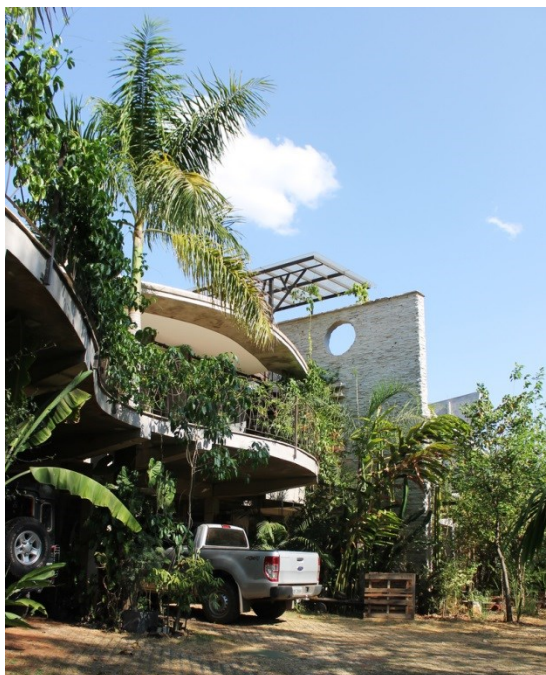
Figura 11: Foto Fachada Oeste 1
