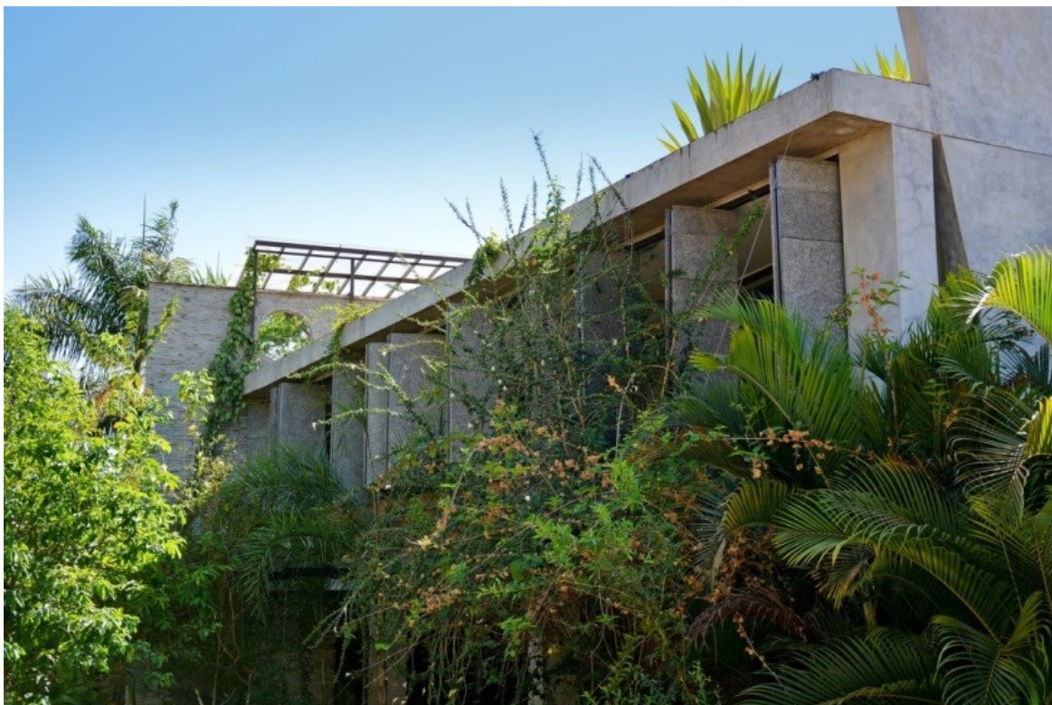
Figura 13: Foto Fachada Oeste 3
