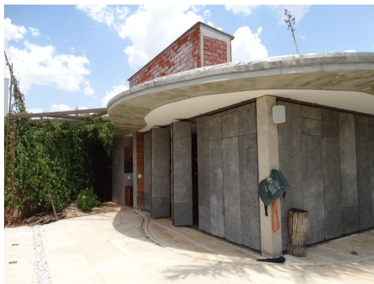
Figura 15: Foto Fachada Norte
