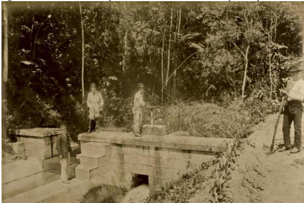
Figura 11 - Trabalhadores da Companhia Cantareira realizando manutenção em aquedutos
