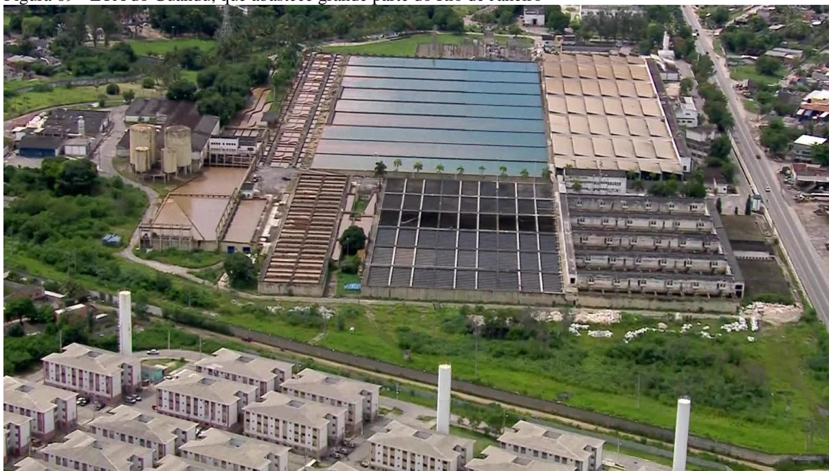
Figura 69 - ETA do Guandu, que abastece grande parte do Rio de Janeiro
