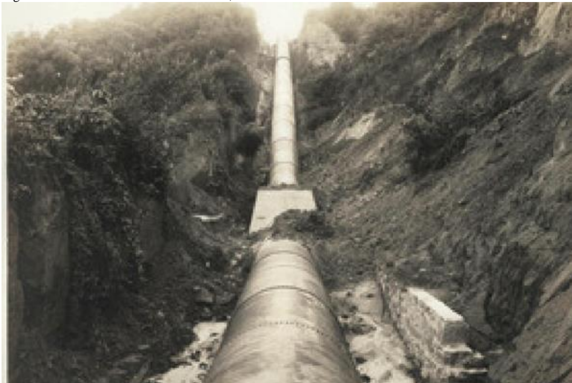
Figura 12 - Adutora do Sistema Rio Claro, da SABESP
