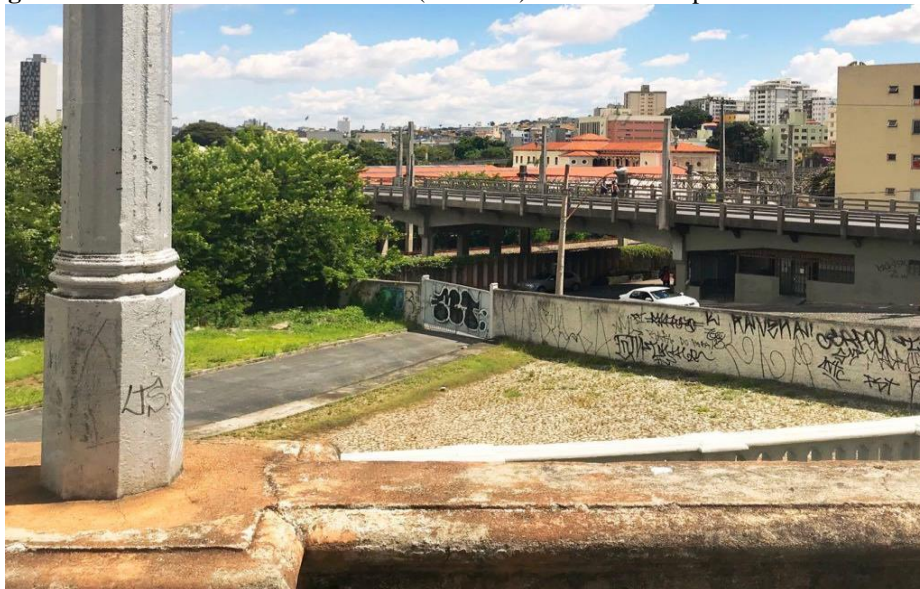
Figura 1- Início do Viaduto da Floresta (ao fundo) visto da rua Sapucaí. Data: 30/05/2019
