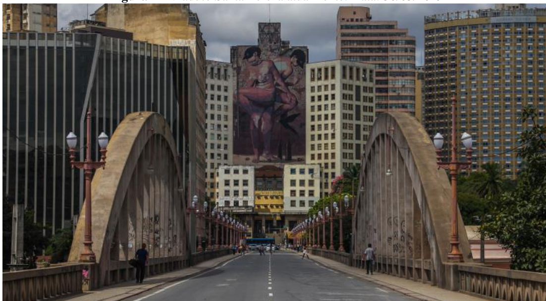
Figura 7 - Viaduto Santa Tereza atualmente. Data: 30/05/2019
