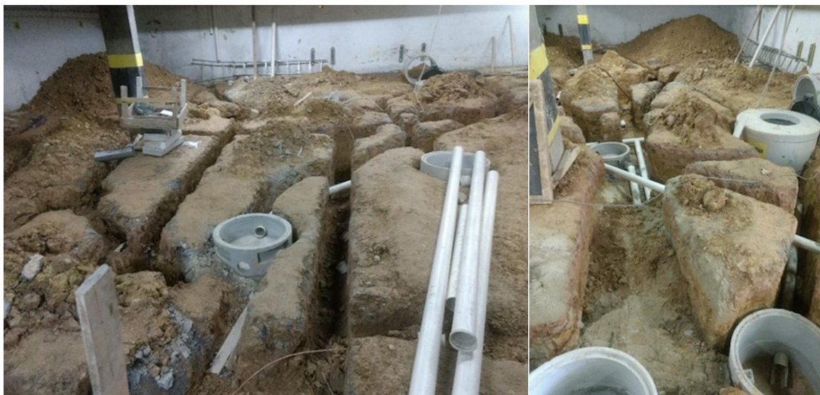
Figura 67 – Execução de rede de esgotamento hidrossanitário no subsolo.
