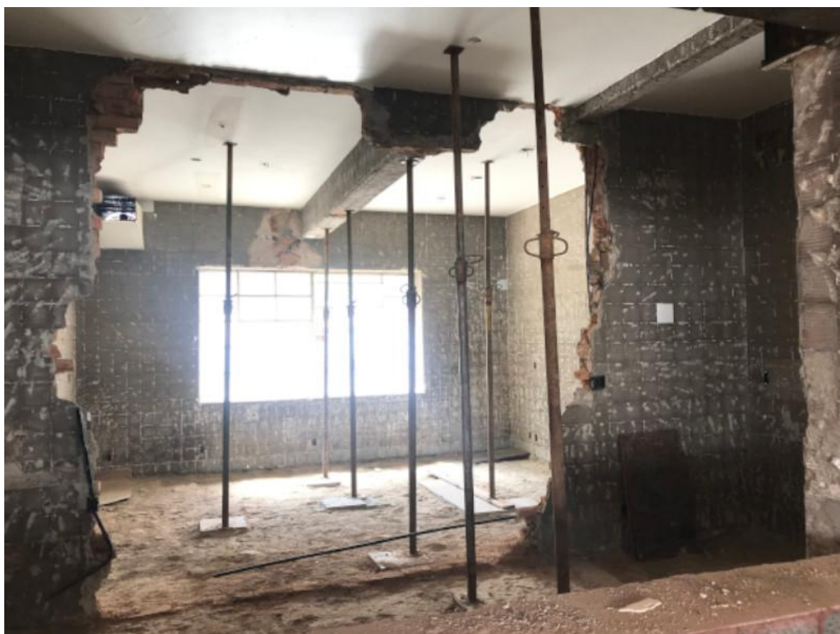
Figura 93 – Demolições internas – viga descarregando em alvenaria.
