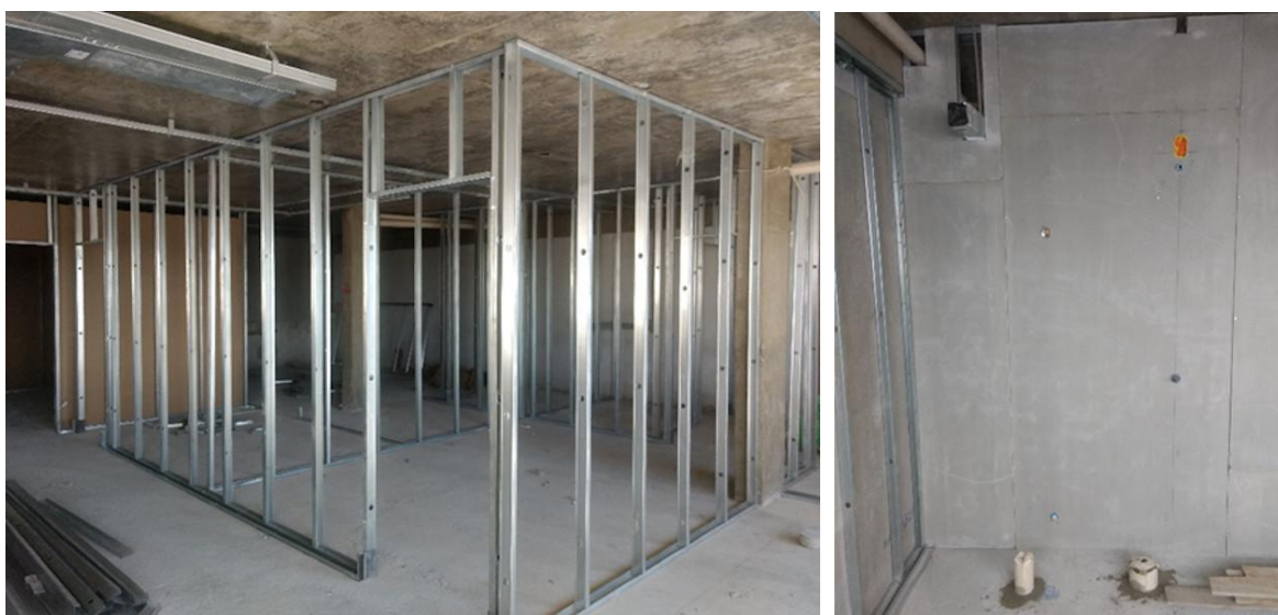
Figura 35 – Fechamento interno sistema construtivo de drywall com gesso acartonado.
