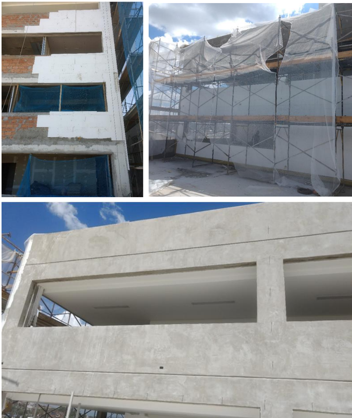
Figura 53 – Processo executivo do sistema EIFS – preenchimento com placas de EPS.
