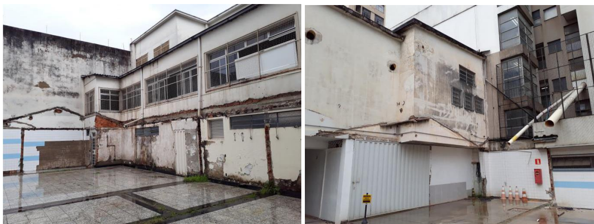
Figura 84 – Pátio interno descoberto vista da unidade de serviços.
