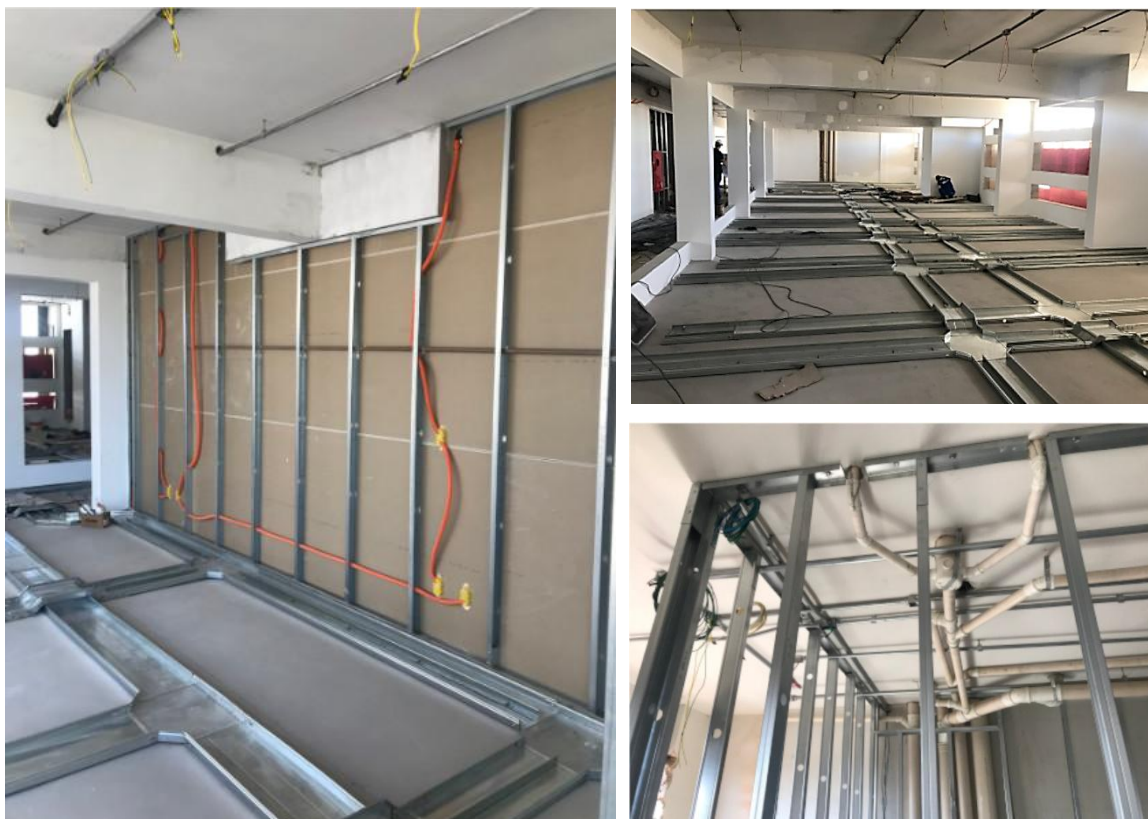
Figura 80 – Fechamento interno em sistema construtivo de drywall com gesso.
