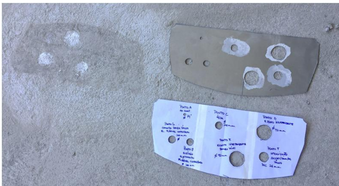
Figura 71 – Marcação da infraestrutura de acordo com gabarito do fabricante.
