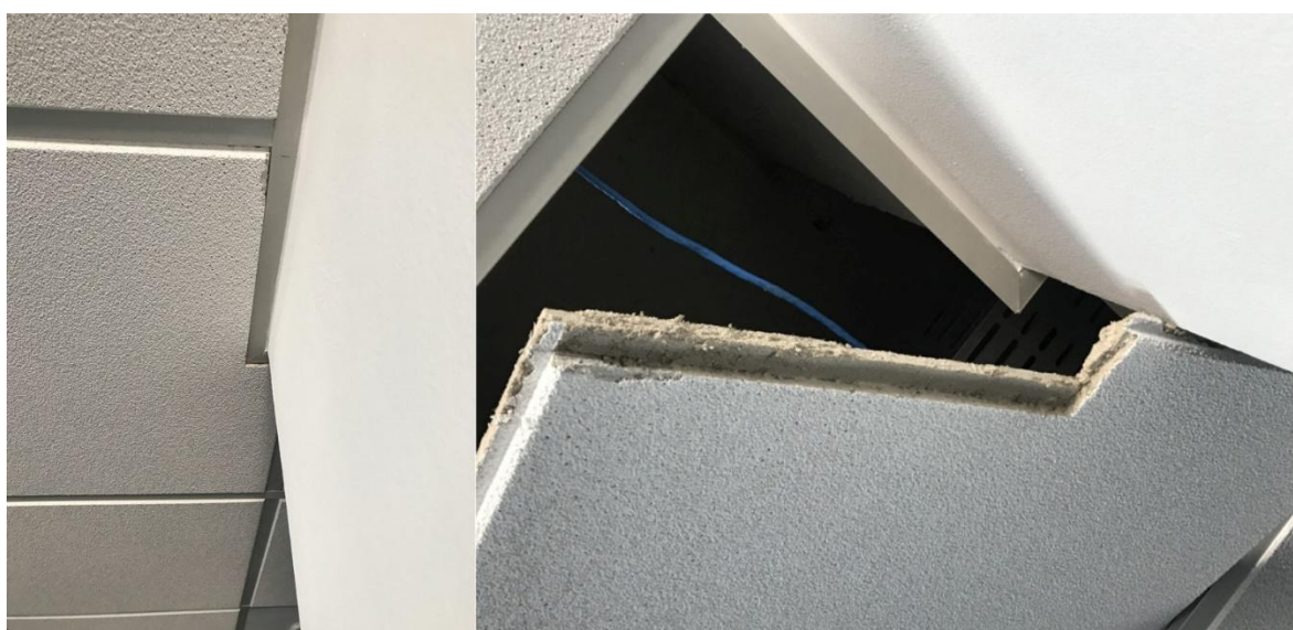
Figura 102 – Forro mineral tegular existente no 15º pavimento com recorte nas placas.
