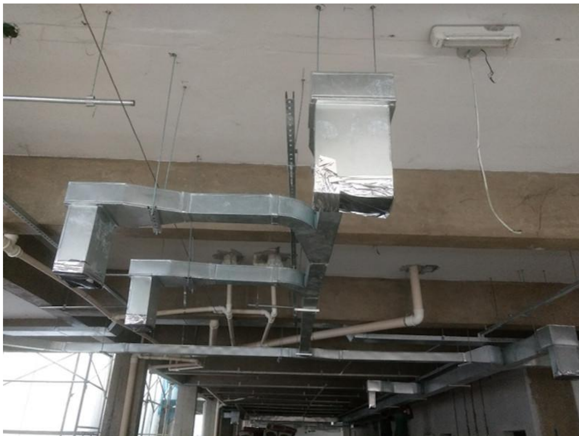
Figura 36 – Instalação das infraestruturas prediais no entreferro.
