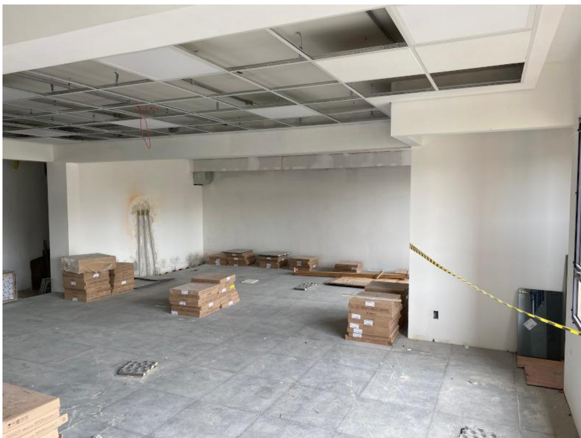
Figura 103 – Forro mineral tegular instalado no 13º pavimento com tabeira de gesso.
