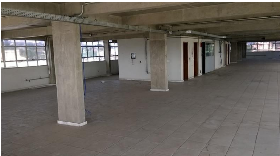
Figura 33 – Exemplo de pavimento tipo antes do início das obras.
