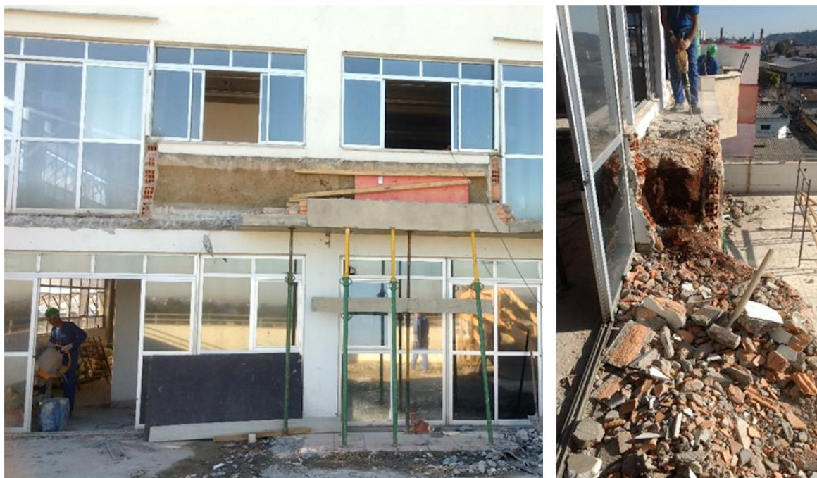
Figura 48 – Demolição de varanda e jardineira na fachada frontal.
