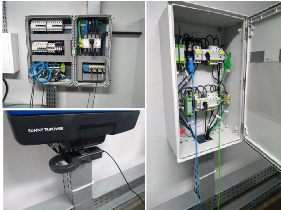
Figura 6 – Fotos dos sensores e instrumentos instalados para amostragem dos dados do inversor SMA.
