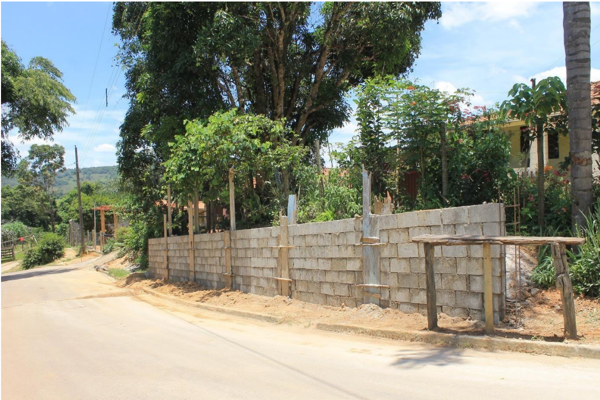
Figura 45: Fachada de uma casa em Pedras, com destaque para o muro construído a fim de evitar os impactos do trânsito de caminhões.
