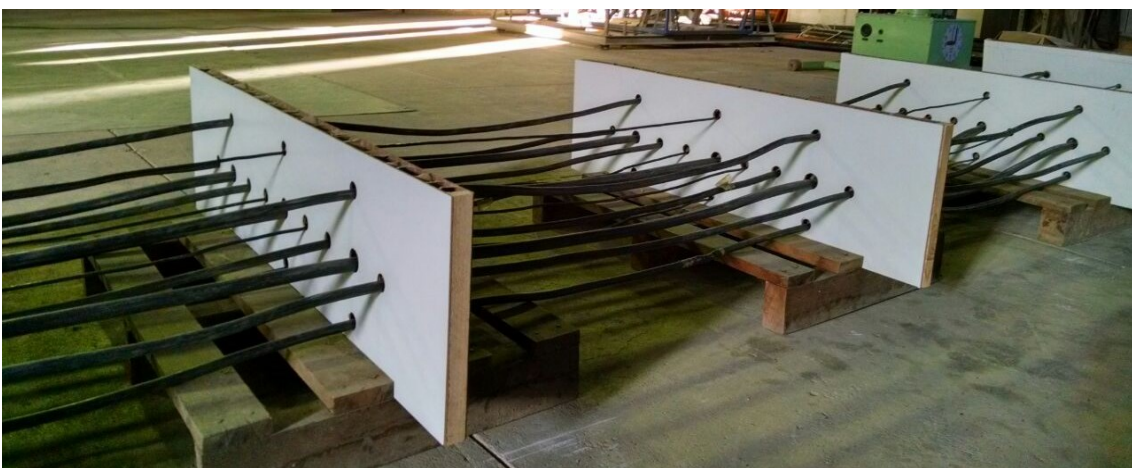
Figura 4.20 - Disposição dos loops na montagem da blindagem do HMCPL realizada no LEAT.
