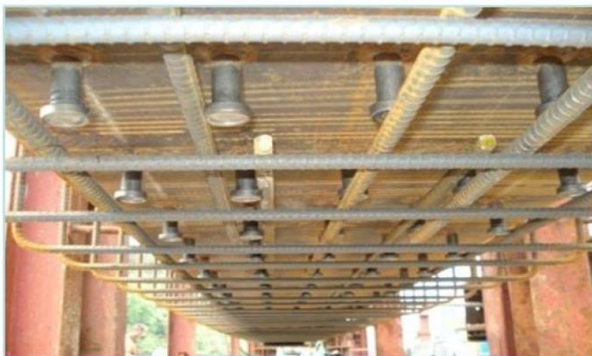
Figura 1-3 – Conectores de cisalhamento e barras de armadura longitudinal e transversal instalados na mesa inferior de aço. Fonte: Valdes et al. ,2010.
