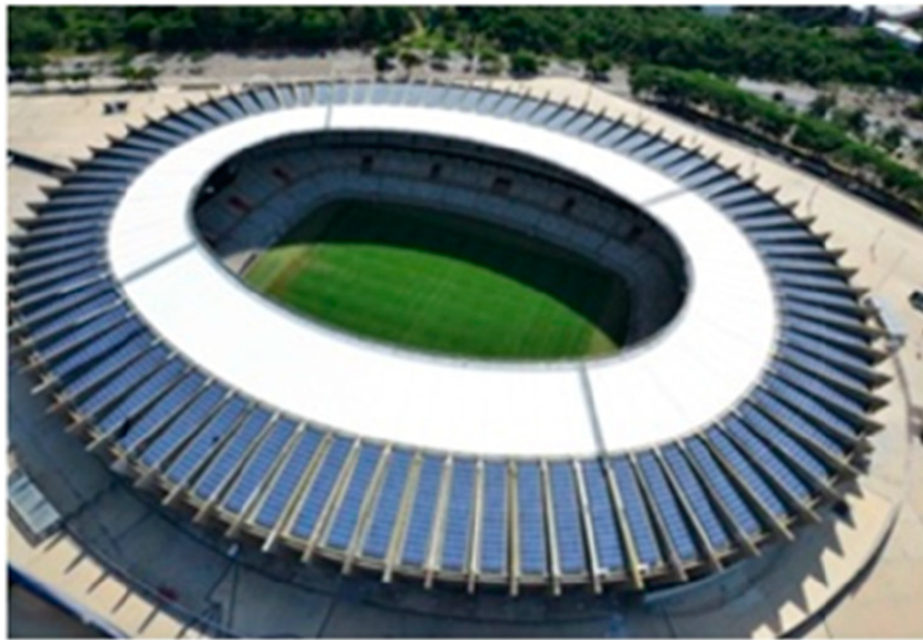
Figura 28 – Usina Fotovoltaica do estádio Mineirão. Retirado de (MONTEIRO et al., 2017)
