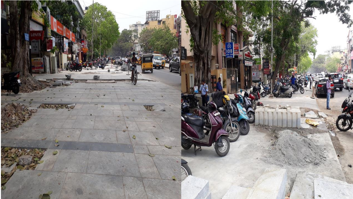
Figura 18 - Obras de construção. Pedestrian Plaza, projeto da SCM-Chennai. T. Nagar, Chennai-TN. Índia. Fonte: Acervo do autor
