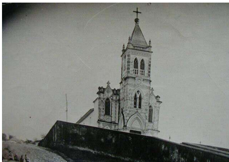
Figura 27: Fachada da igreja do Rosário supostamente após reforma
