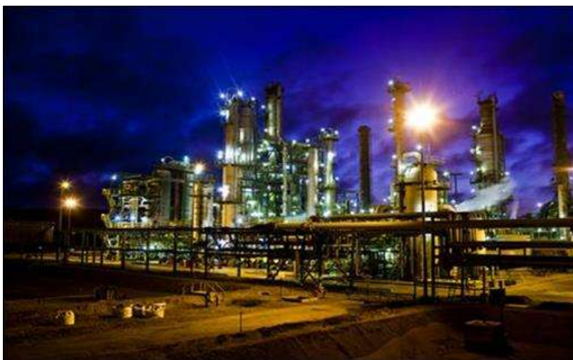
Figura 2.10: Refinaria “Talara” (Fonte: PETROPERU.COM.PE, 04/07/2014)
