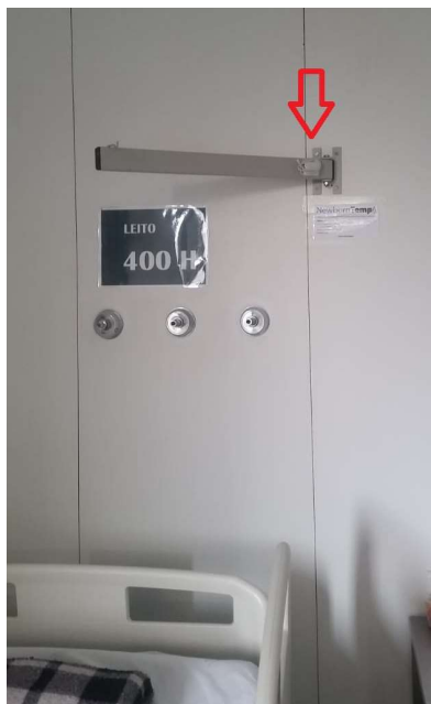
Figura 6 – Sensor posicionado na sala de pré-parto, para monitorar temperatura ambiente
