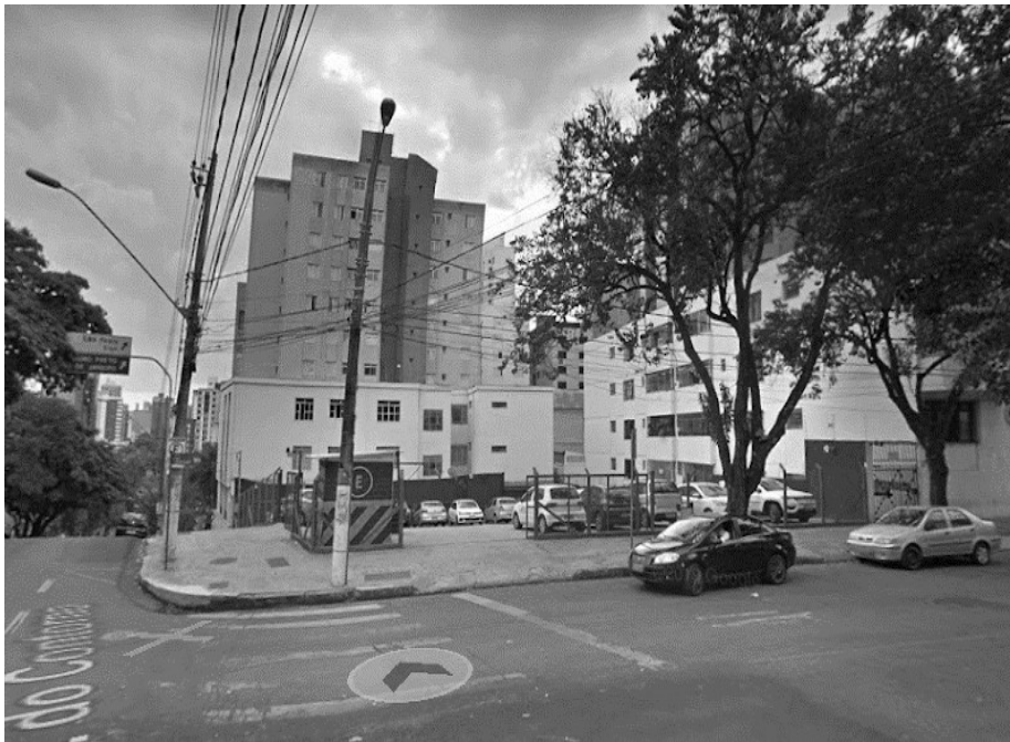
Figura 48 - Lote de difícil ocupação em função da legislação localizado na Avenida do Contorno, esquina com Rua Piauí
