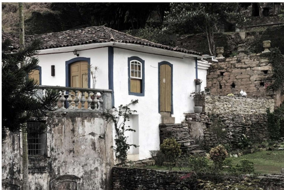
Figura 15 – Construção em estilo colonial em Ouro Preto
