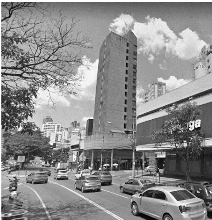
Figura 46 - Exemplo de edifício com “bandeja” na esquina da Avenida do Contorno com Rua Grão Mogol
