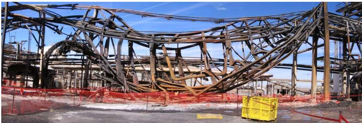
**Figura 18** – Colapso em Pipe Rack devido a incêndio
