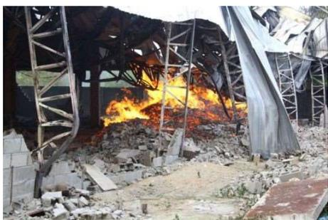
**Figura 10** – Elemento de aço exposto ao fogo
