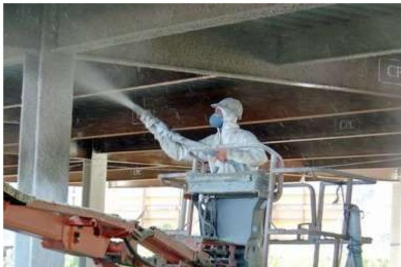
**Figura 14** – Aplicação de argamassa projetada
