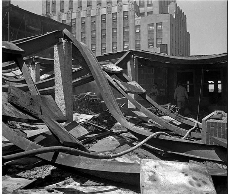
**Figura 3** - Vigas em aço do Edifício Bressmer retorcidas após incêndio
