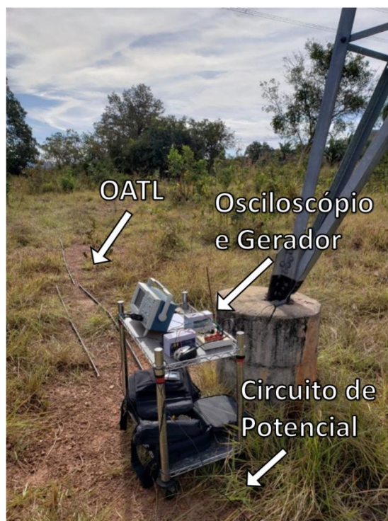
Figura 5.21 – Montagem da medição impulsiva na Torre 56 (autoportante) da LT 230 kV, utilizando o OATL no circuito de corrente.
