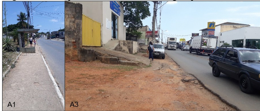
Figura 71: Exemplos de infraestrutura drenagem pluvial – Trecho 2
