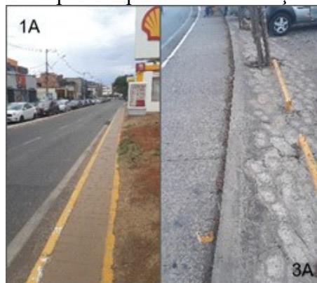
Figura 41: Exemplos de pavimento da calçada – Trecho 1
