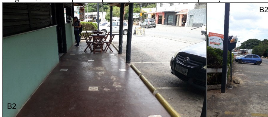
Figura 77: Exemplos de presença de barreiras de proteção – Trecho 2
