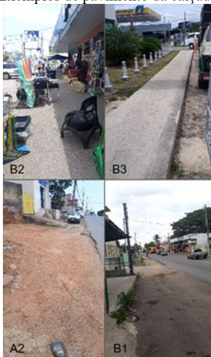
Figura 42: Exemplos de pavimento da calçada – Trecho 2
