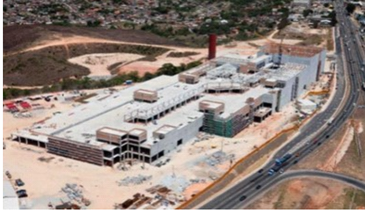
Figura 28: Área remanescente do Contorno Viário de Betim
