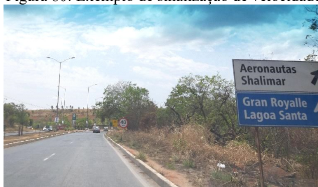
Figura 80: Exemplo de sinalização de velocidade
