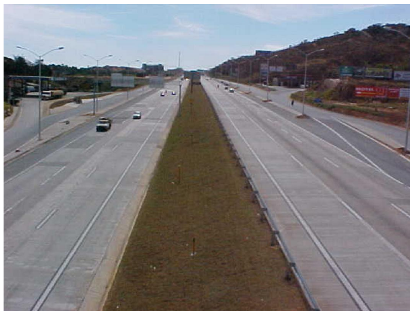
Figura 4 – Pavimento de concreto – MG 010
