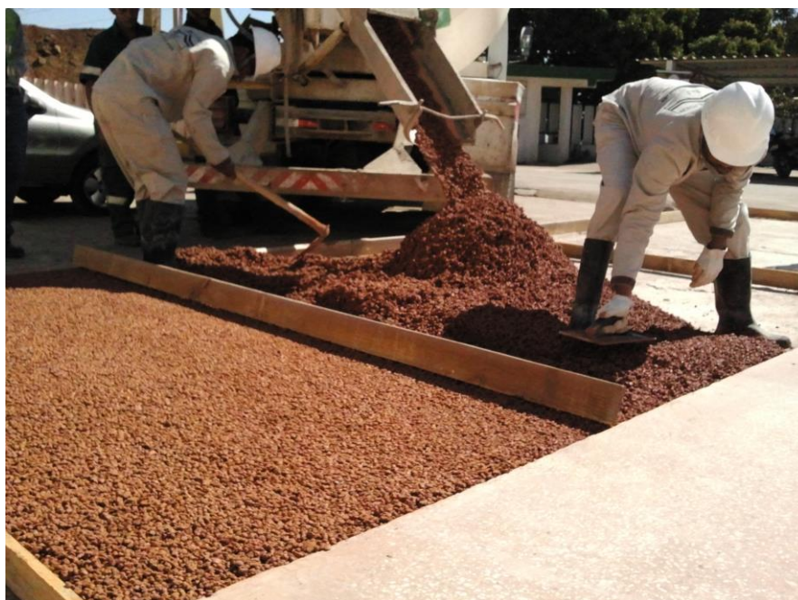
Figura 17 – Aplicação de concreto moldado no local para um estacionamento
