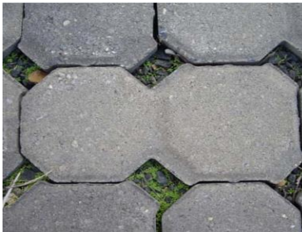
Figura 9 – Pavimento constituído por peças de concreto com áreas vazadas
