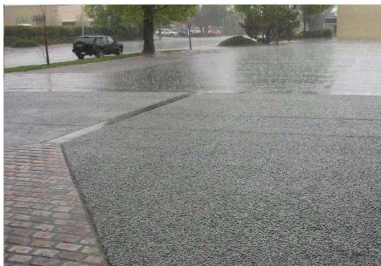
Figura 12 – Pavimento revestido com concreto permeável moldado no local
