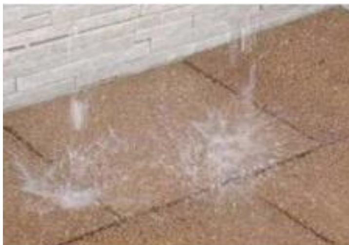
Figura 11 - Revestimento de pavimento de placas de concreto
