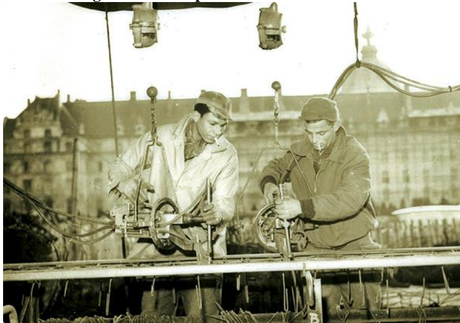
Figura 19 – Soldagem manual a ponto nos anos 50 na indústria automotiva.
