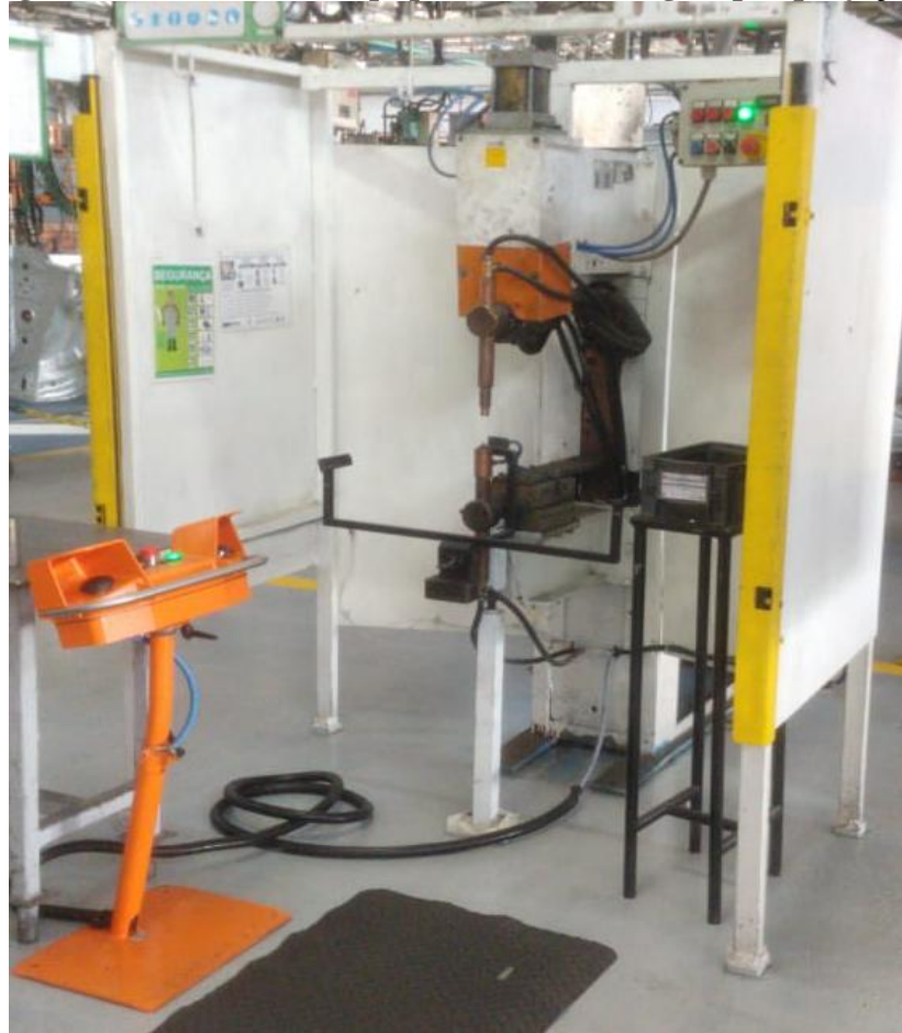
Figura 27 – Célula com equipamento de sodagem por projeção.
