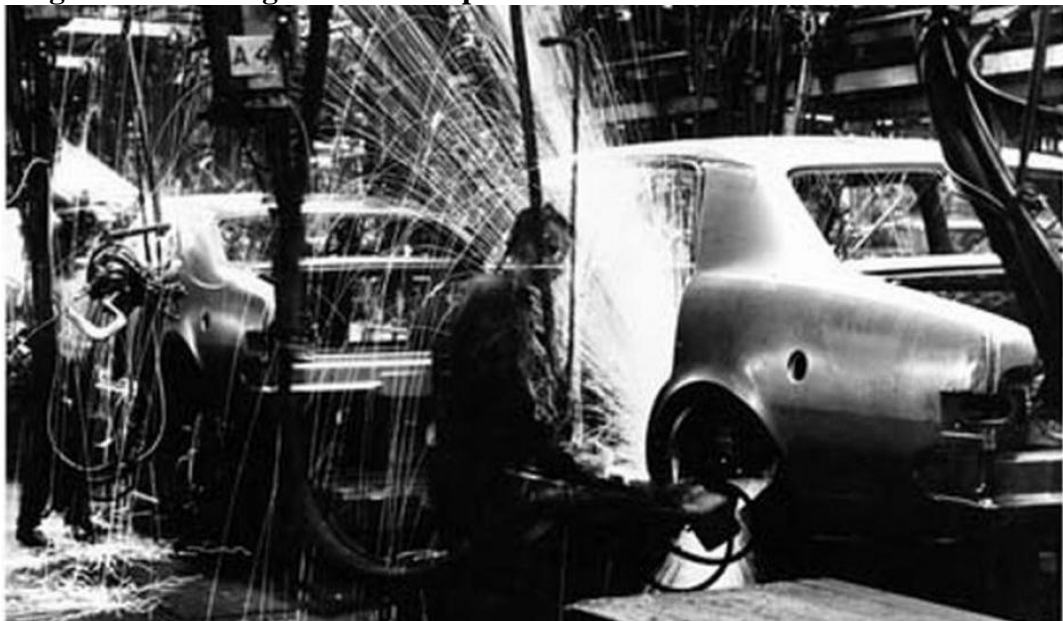
Figura 20 – Soldagem manual a ponto nos anos 60 na indústria automotiva.
