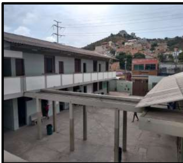
Figura 7: Vista do Pátio de entrada da Escola Municipal da Vila Pinho
