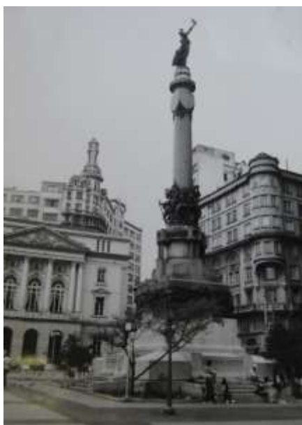
Figura 31 - Monumento Glória Imortal aos Fundadores de São Paulo, São Paulo - SP. Fonte: Uhle (2015)
