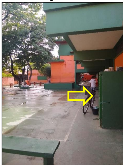
Figura 14 – Casa de gás no exterior da cozinha
