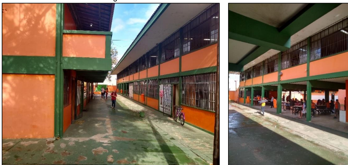
Figura 12 - Áreas comuns entre os blocos 1 e 2
