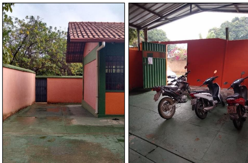
Figura 6 - Saídas para o exterior da escola
