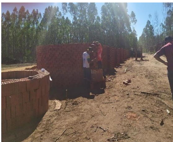
Figura 21 - Comunitários trabalhando na construção dos fornos
