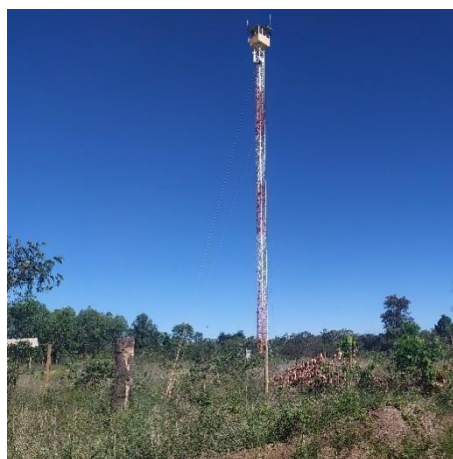
Figura 27 - Câmera que tem rotação de 360° e vigia um raio considerado do plantio de eucalipto.
