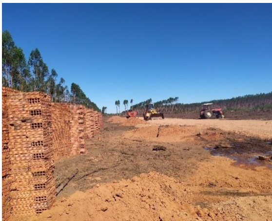
Figura 19 - Maquinário na construção dos fornos.
