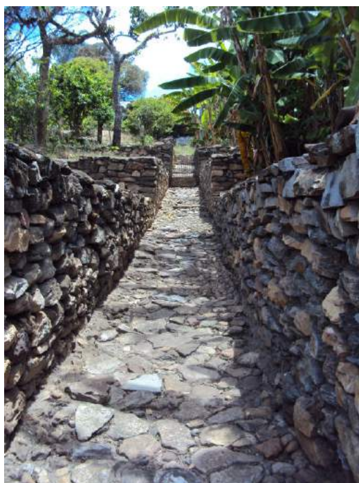
Figura 91 – Patamares de nível em alvenaria de pedra no Quintal da Casa da Chica da Silva, Diamantina (MG)
