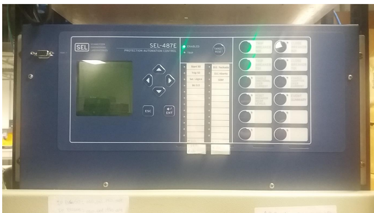
Figura 4.17 – Relé SEL-487E utilizado para avaliar o desempenho da metodologia de testes proposta.
