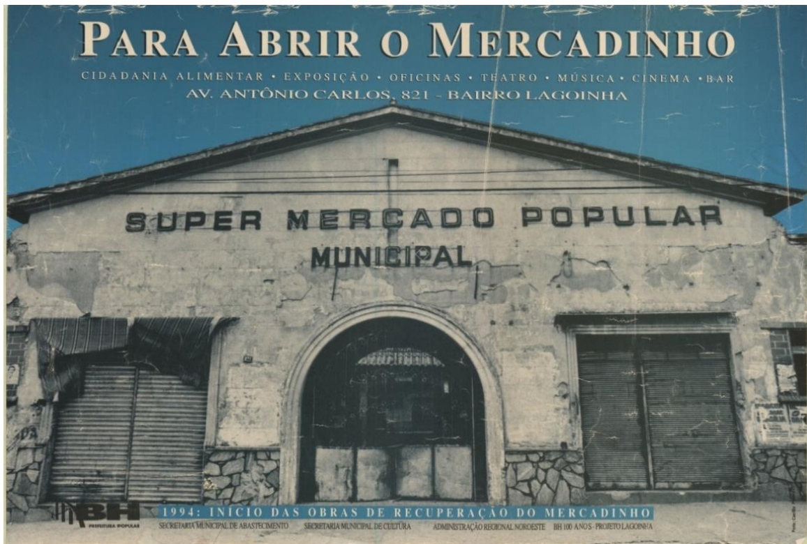
Figura 24 - Cartaz para divulgação do início das obras de recuperação do Mercado da Lagoinha (1994)
