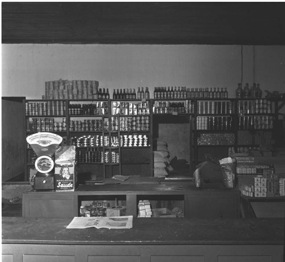
Figura 20 - Armazém Regulador/ Departamento de Abastecimento/ PBH (1963)
