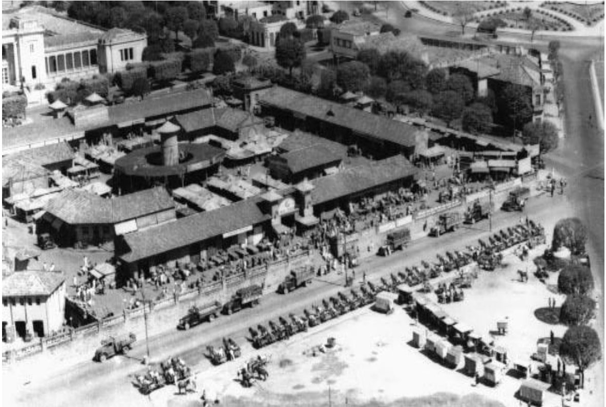
Figura 11 - Vista panorâmica do Mercado Central de Belo Horizonte (1947)
