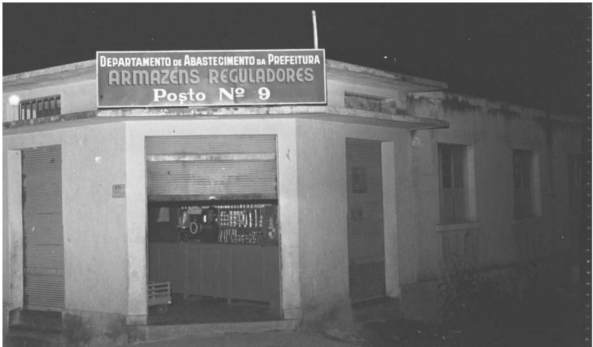
Figura 12 - Armazém Municipal n. 9 (12 de maio de 1960)
