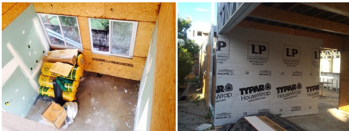
Figura 60. Residência E.F., etapas internas de obra
