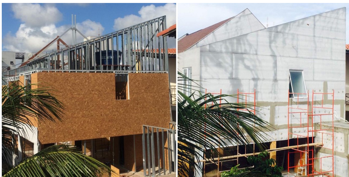
Figura 57. Residência E.F., etapas externas de obra
