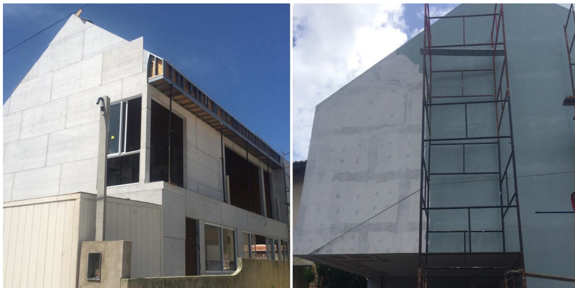
Figura 58. Residência E.F., etapas finais de obra
