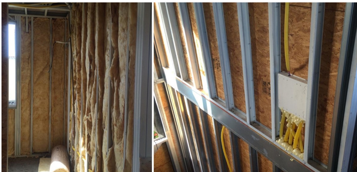
Figura 62. Residência E.F., insulamento, perfis e instalações
