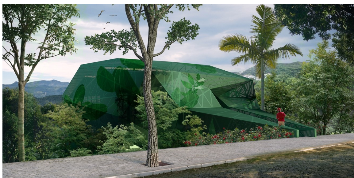
Figura 76. Fundação Éolo Maia, edificação vista da rua
