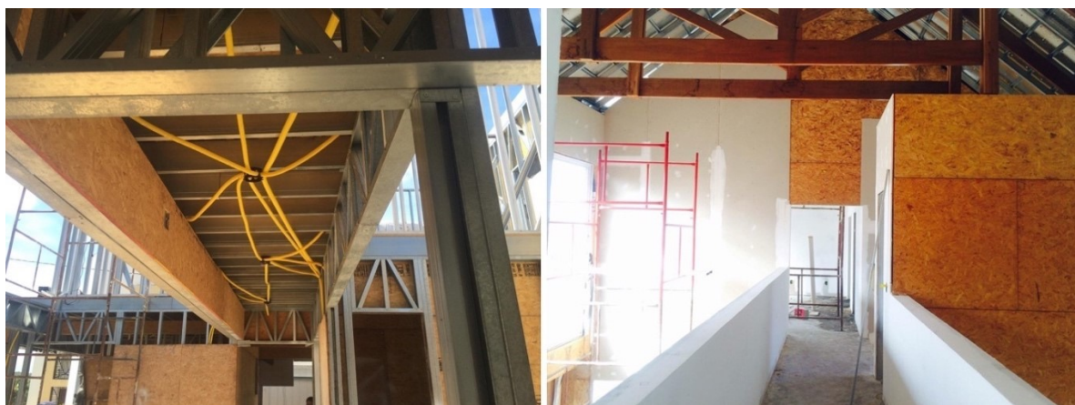
Figura 59. Residência E.F., etapas internas de obra
