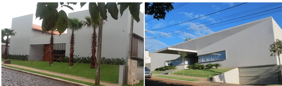
Figura 56. Residências Foz2 (2013) e Foz1 (2012)
