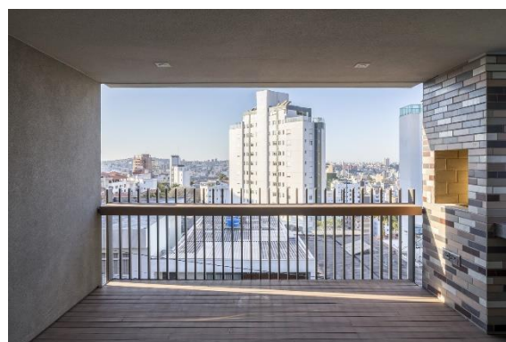
Figura 75 – Guarda-corpo no Residencial Flor de Liz Fonte: Gabriel Castro (Edifício Residencial Flor de Liz / Play Arquitetura, 2017).
