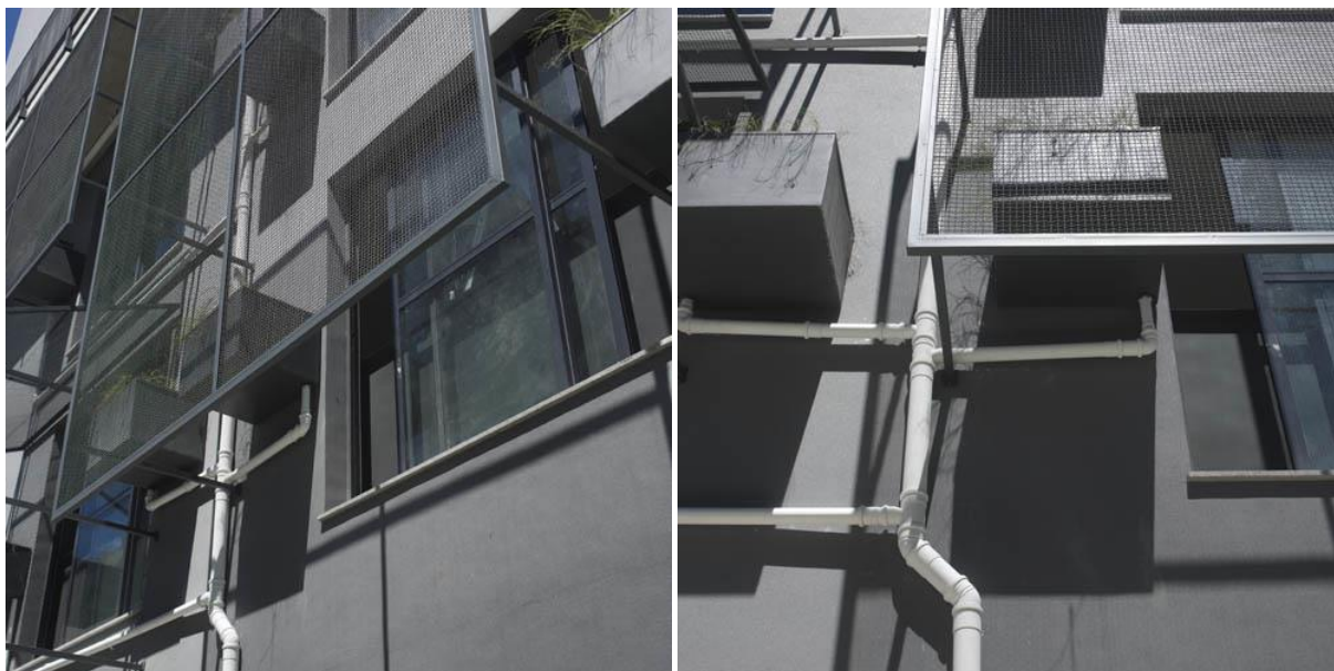
Figura 49 – Elementos na fachada leste do Montevideu 285 Fonte: Vazio S/A (2012).
