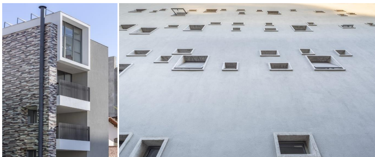
Figura 48 – Fachadas frontal e oeste do Residencial Flor de Liz Fonte: Gabriel Castro (Edifício Residencial Flor de Liz / Play Arquitetura, 2017).
