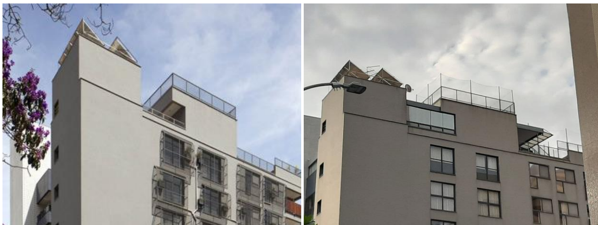
Figura 92 – Antes e depois da cobertura do Montevidéu 285 Fonte: Vazio S/A (2012). Fotografia do autor, 2020.
