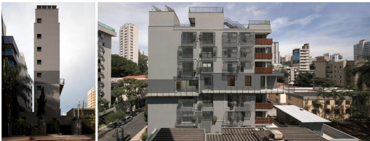
Figura 45 – Fachadas frontal e leste do Montevideu 285 Fonte: Vazio S/A (2012).
