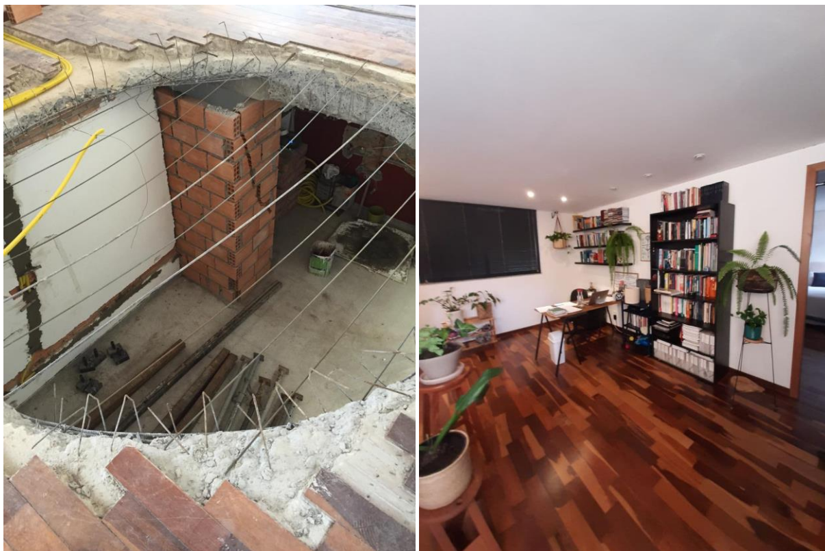
Figura 96 – Armação da laje e vão coberto em unidade dos Estúdios Capelinha Fonte: Fotografia enviada pelo morador. Fotografia do autor, 2020.
