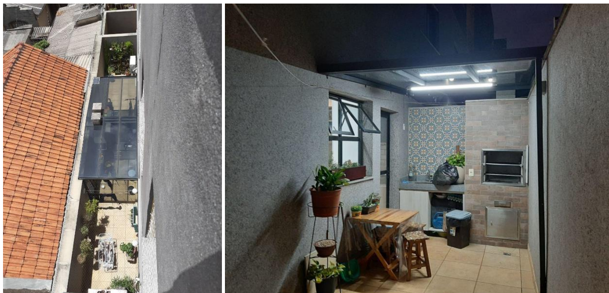
Figura 90 – Coberturas das áreas privadas do Residencial Zider Fonte: Fotografias do autor, 2020.
