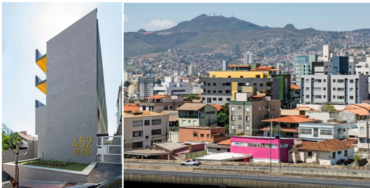
Figura 47 – Fachadas norte e leste do Residencial Zider Fonte: Izabel Diniz (MEIUS ARQUITETURA, 201-).
