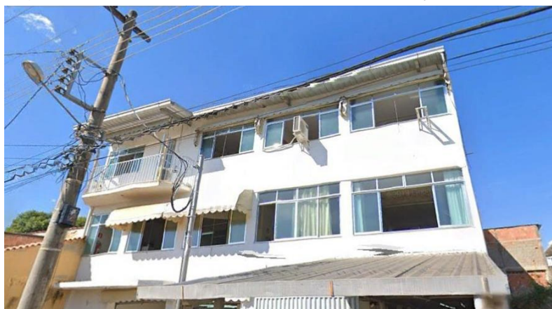
Figura 40 – Edifício adaptado para confecção de bairro
