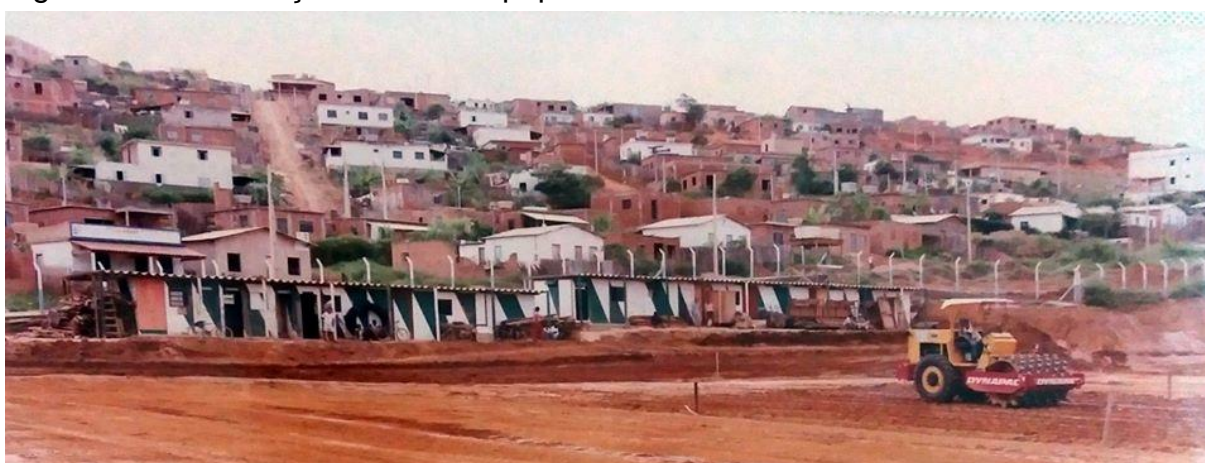
Figura 32 – Construção das casas populares no bairro Três Marias
