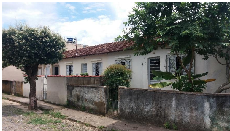
Figura 26 – Residências pioneiras no bairro Popular
