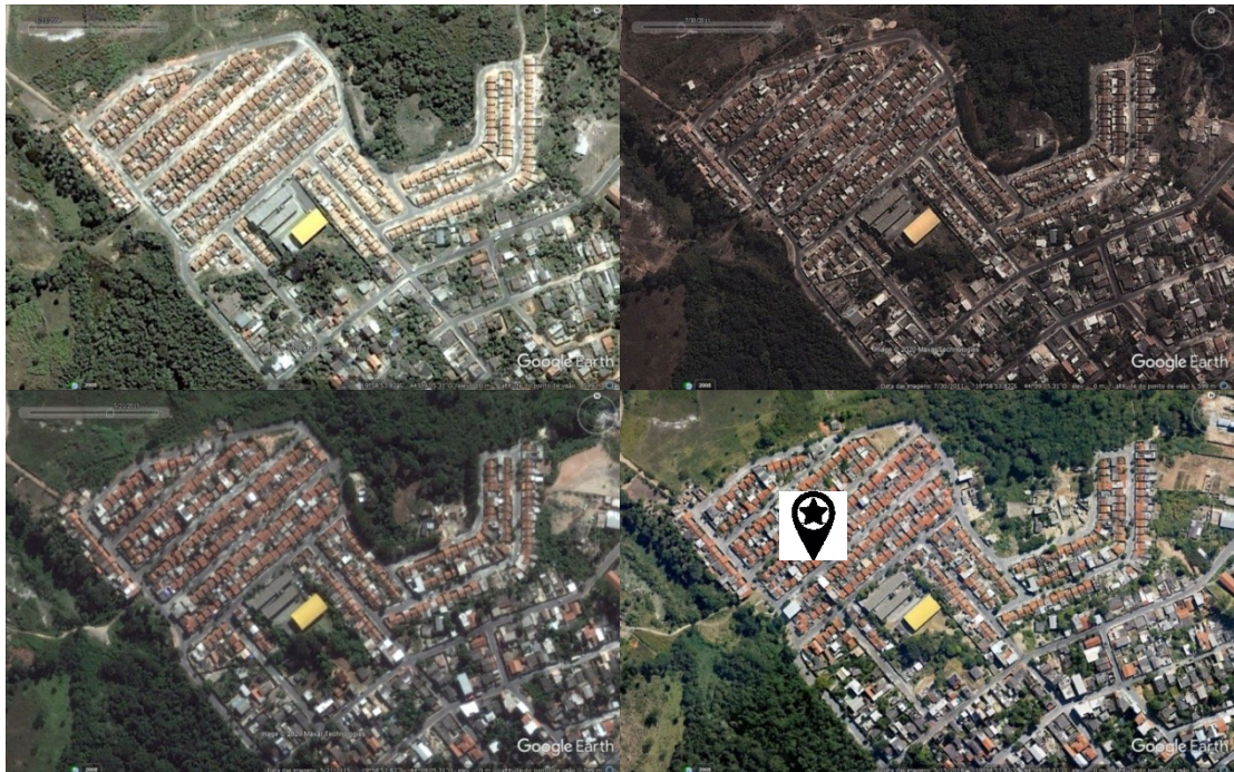
Imagens de Satélite 2008-2011-2015-2020. Fonte: Google Earth. Acesso em Abril de 2020.
