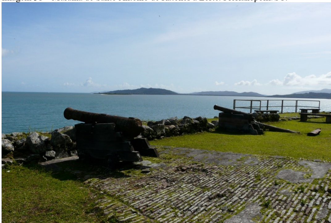
Imagem 31 – Muralha de Santo Antônio de Ratonés à Leste. Florianópolis/SC.
