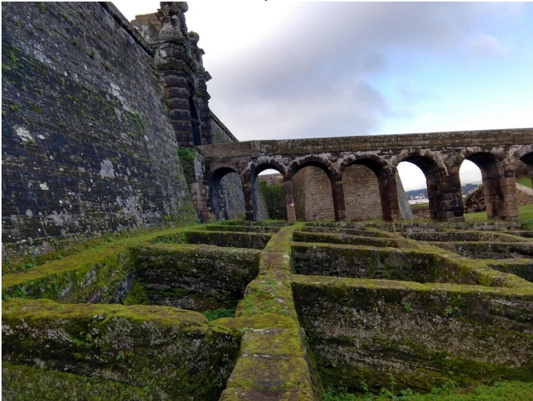
Imagem 13 – Detalhe lateral das escarpas e dos arcos em cantaria para acesso à Porta Magistral. Fortaleza São João Batista. Ilha Terceira. Açores.
