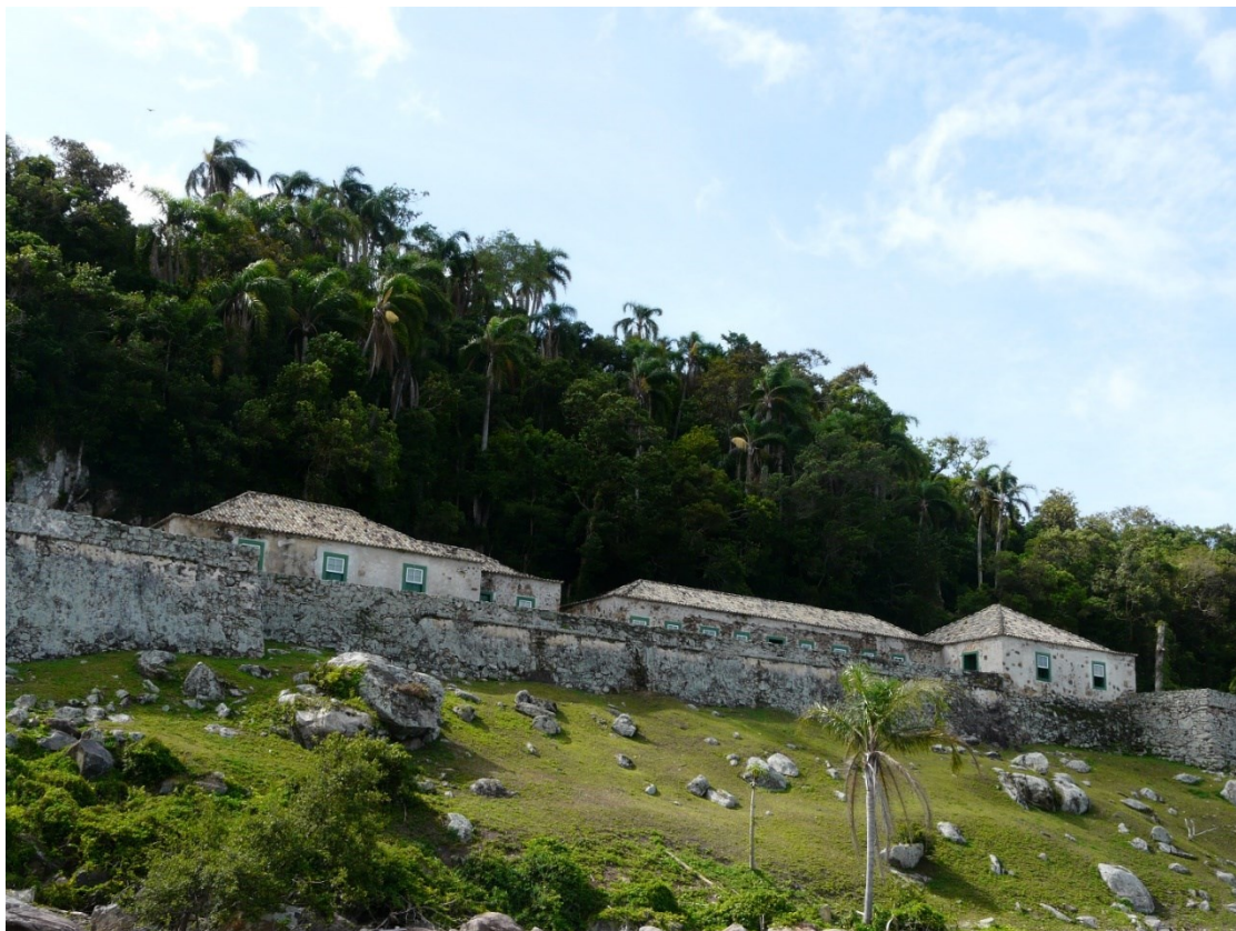
Imagem 29 – Edificações da Fortaleza de Santo Antônio de Ratonés. Florianópolis/SC. Vistas a partir do embarcadouro.
