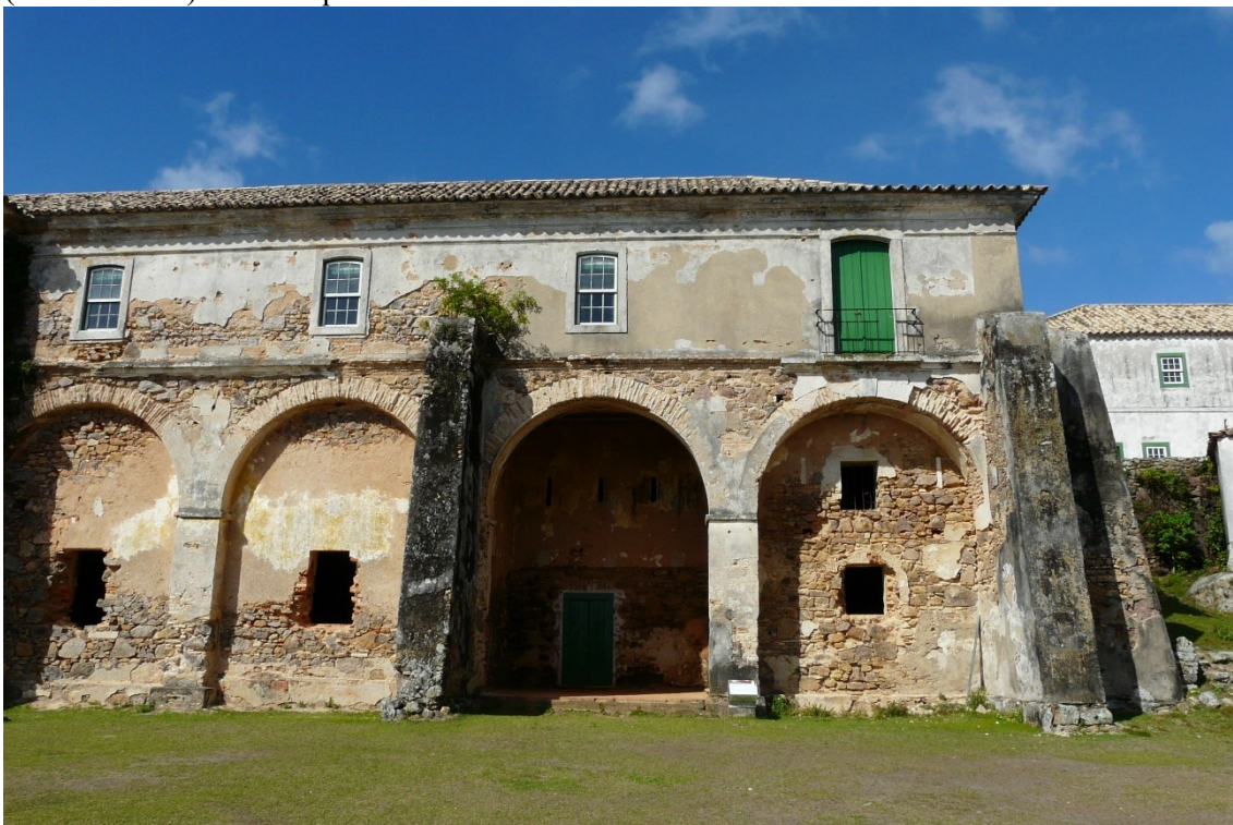
Imagem 37 – Destaque dos contrafortes laterais. – Quartel da Tropa – Fortaleza de Santa Cruz (Anhatomirim). Florianópolis/SC.
