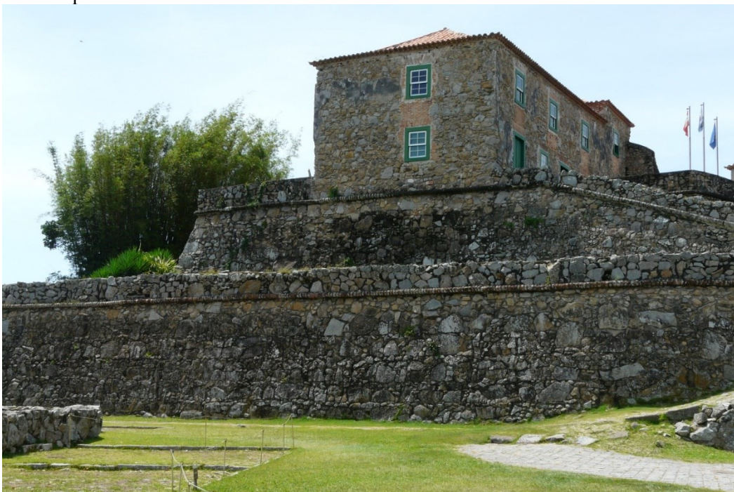
Imagem 27 – Casa do Comandante e Quartéis da tropa, vistos da plataforma intermediária. Florianópolis/SC.
