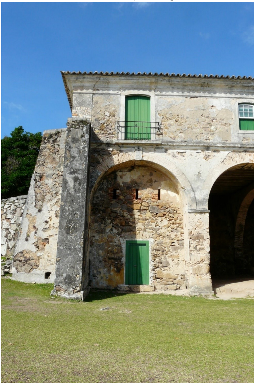
Imagem 35 – Detalhe do fechamento da fachada sem interrupção das arcadas. Quartel da Tropa. Fortaleza de Santa Cruz (Anhatomirim). Florianópolis/SC.
