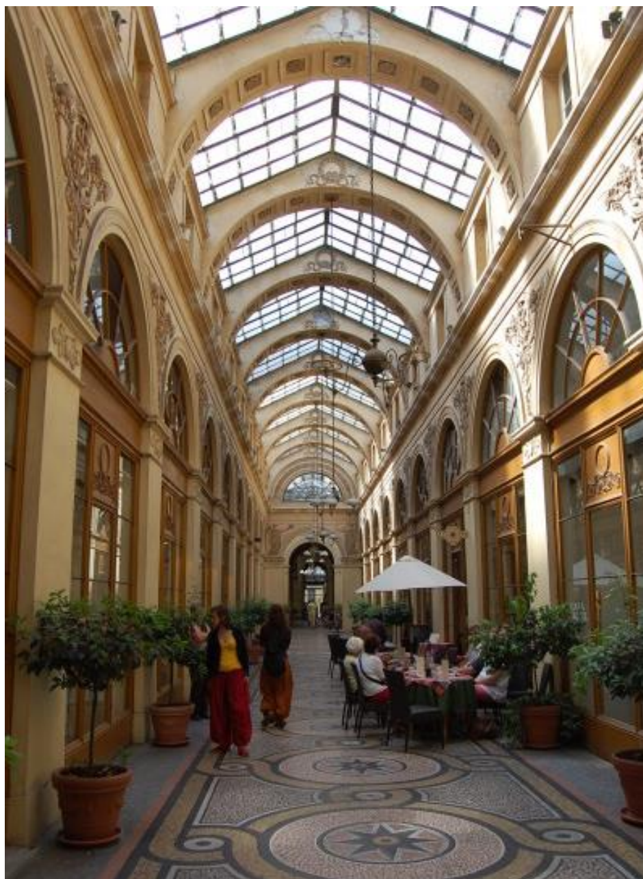
Figura 2 - Galerie Vivienne , Paris. 1823 a 1826. Projetada pelo arquiteto François Jacques Delannoy (1755 – 1835)
