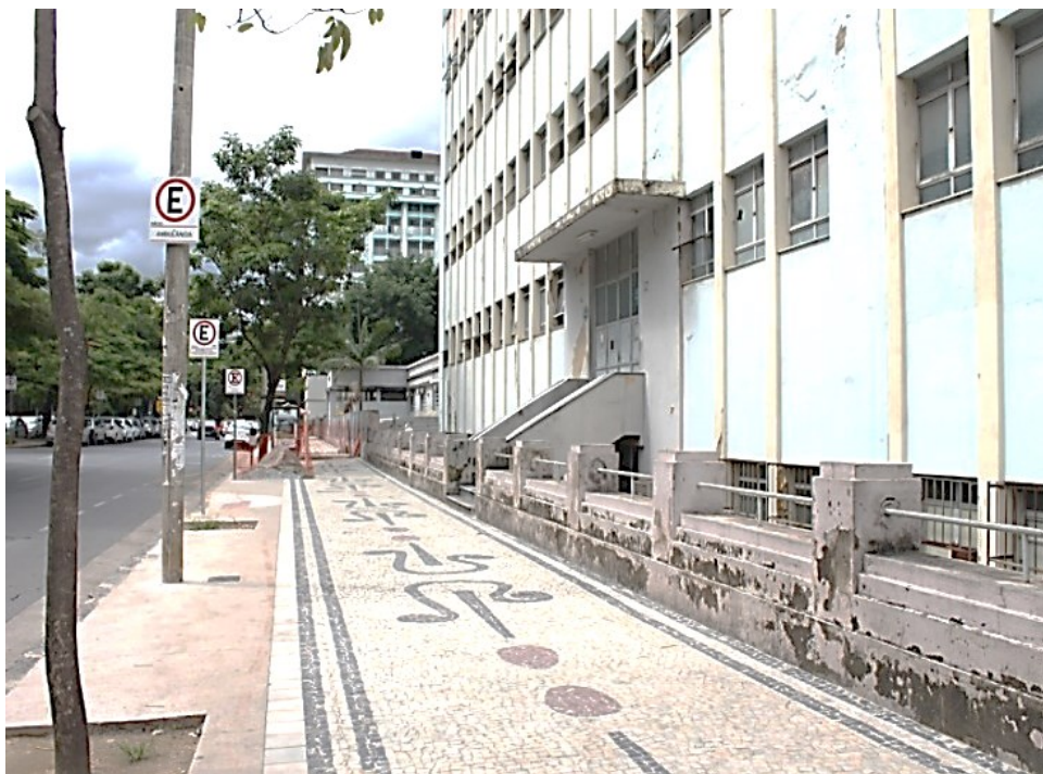
Figura 56 – Tratamento da zona de transição, entre o passeio e o lote
