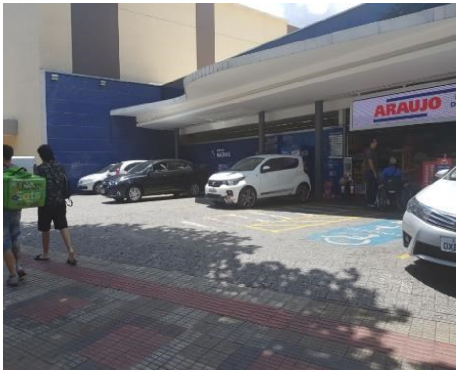
Figura 48 – Estacionamento em afastamento frontal com recuo do passeio para atendimento à farmácia
