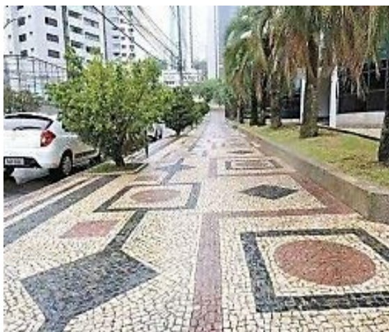
Figura 45 – Passeios: exemplos de revestimentos de Belo Horizonte
