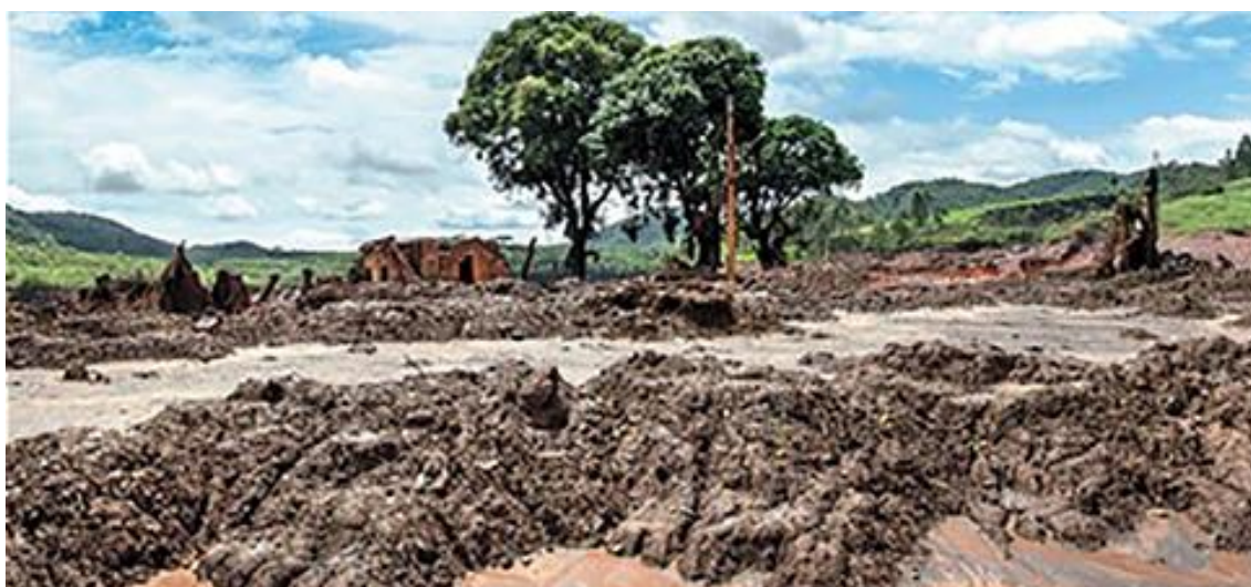
Figura 4 Vista de Bento Rodrigues, após o rompimento da barragem, tomada do mesmo ponto de observação da foto anterior. Fonte: https://www1.folha.uol.com.br . Acesso em 20 de janeiro de 2019.
